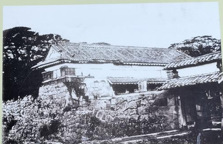
明治5年に銅門が解体される直前の写真で、櫓門の屋根や土塀の傷みが激しく、小田原藩が城を維持できなくなった様子を示しています。
