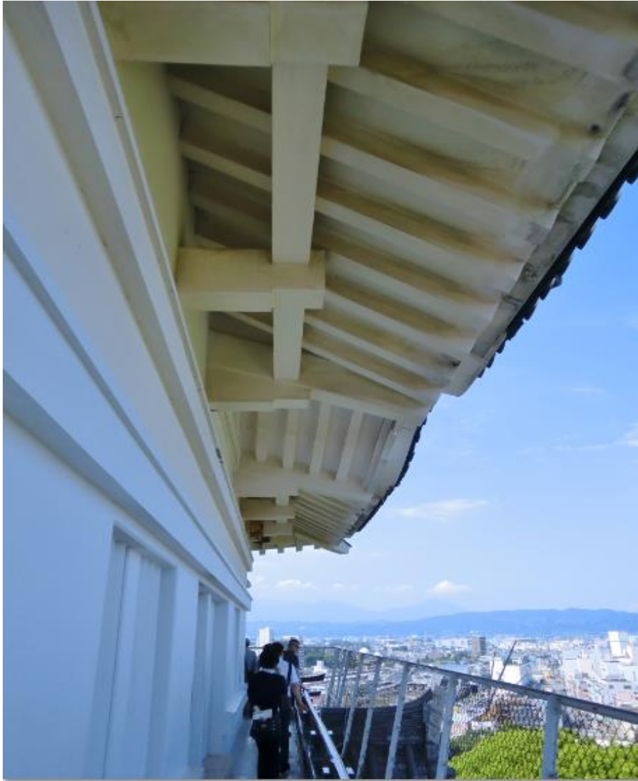
唐破風部分の軒下
