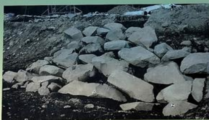
銅門の下から検出された江戸時代初期の野面積みの石垣 矢穴を用いた野面積みの石垣で大久保忠世・忠綱により構築されたものと考えられる Stone walls built in the Edo period, found from under the Akagane-mon Gate (Nozura construction stone walls)
