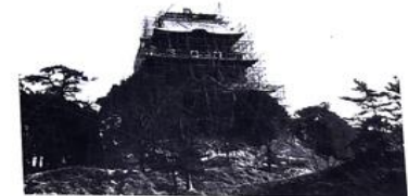
昭和35年 天守閣復興工事 Castle tower reconstruction in 1960
