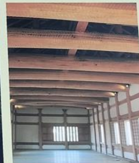
渡櫓内部 Inside the Yagura (turret)
