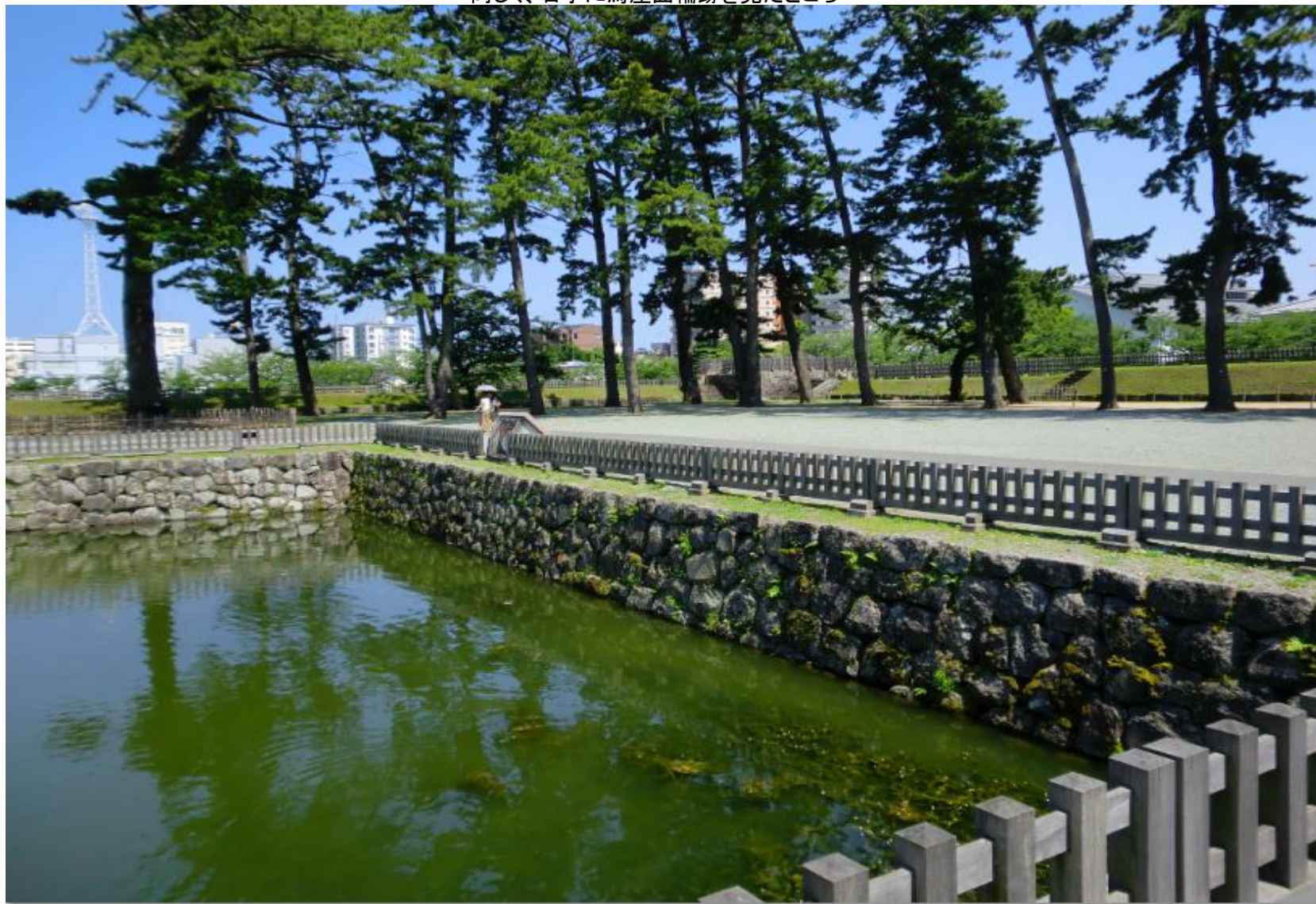
同じく、右手に馬屋曲輪跡を見たところ
