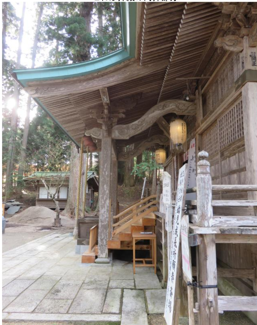
これは拝殿の向拝部分
