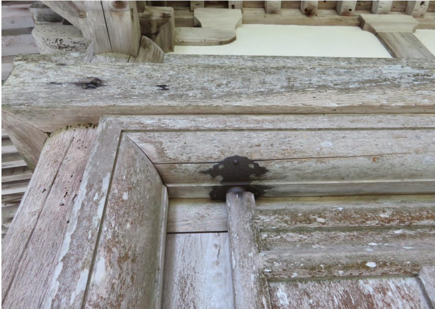
棧唐戸軸吊元の様子
