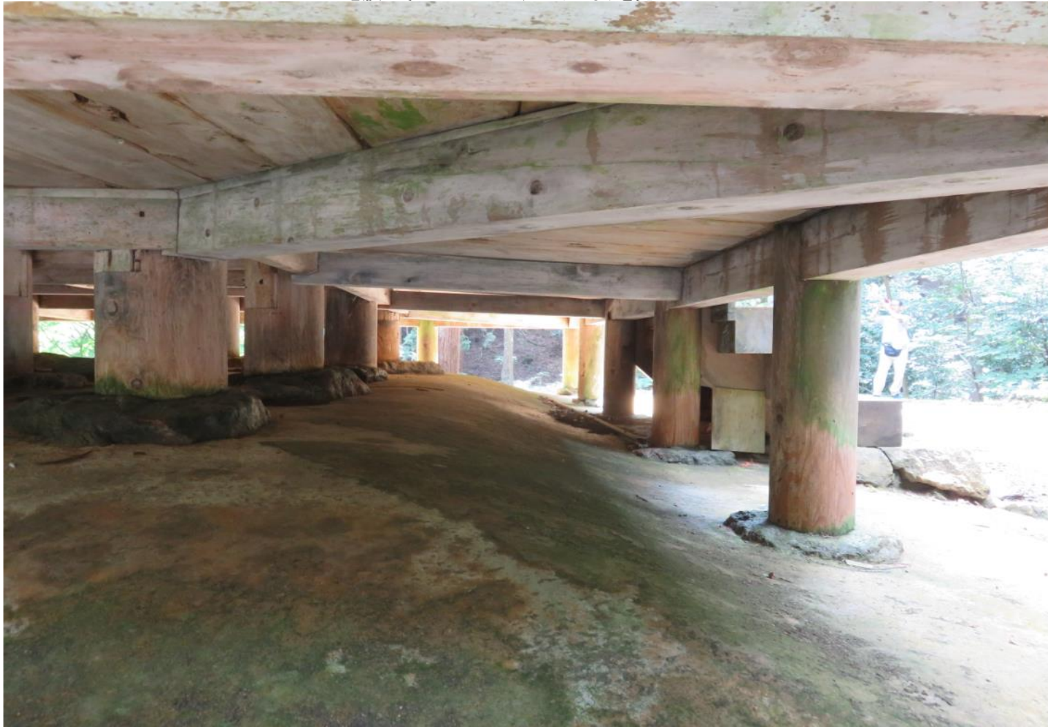
亀腹とその上に立つ礎石(左手)を見たところ
