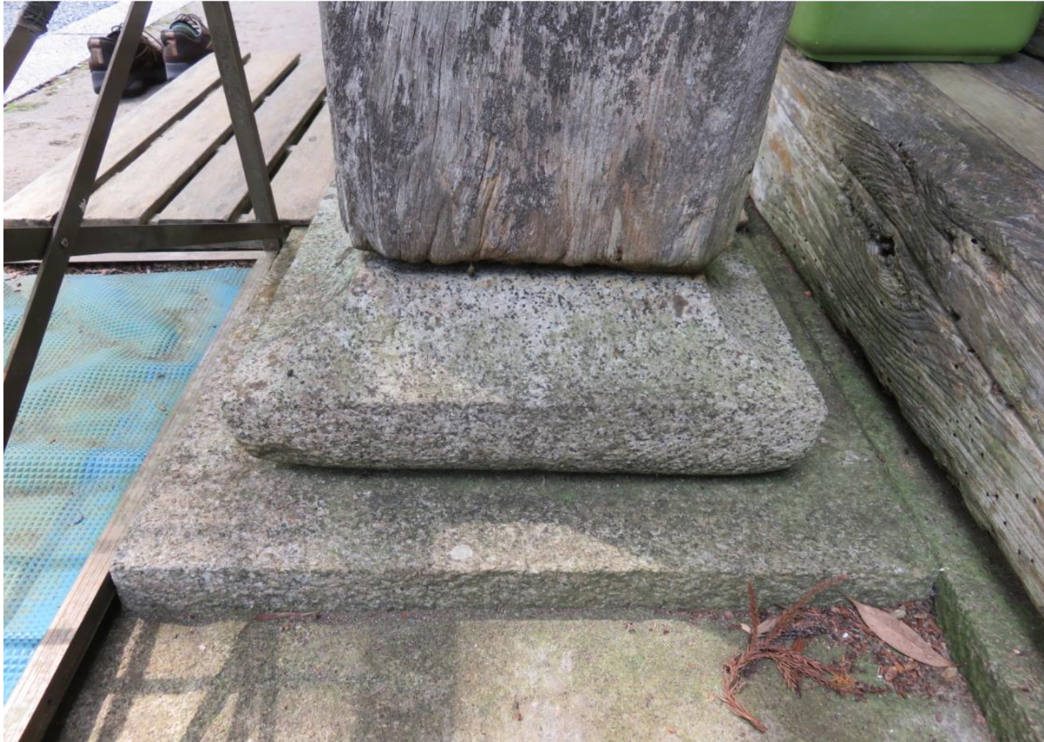
向拝柱下の礎石と礎盤を見たところ
