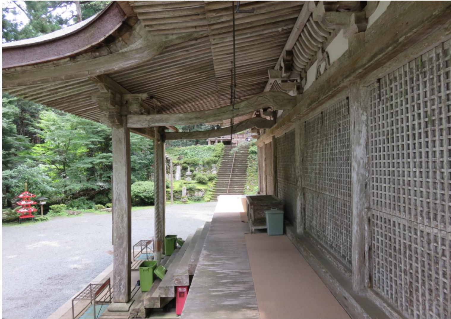
向拝屋根裏を横から見たところ
