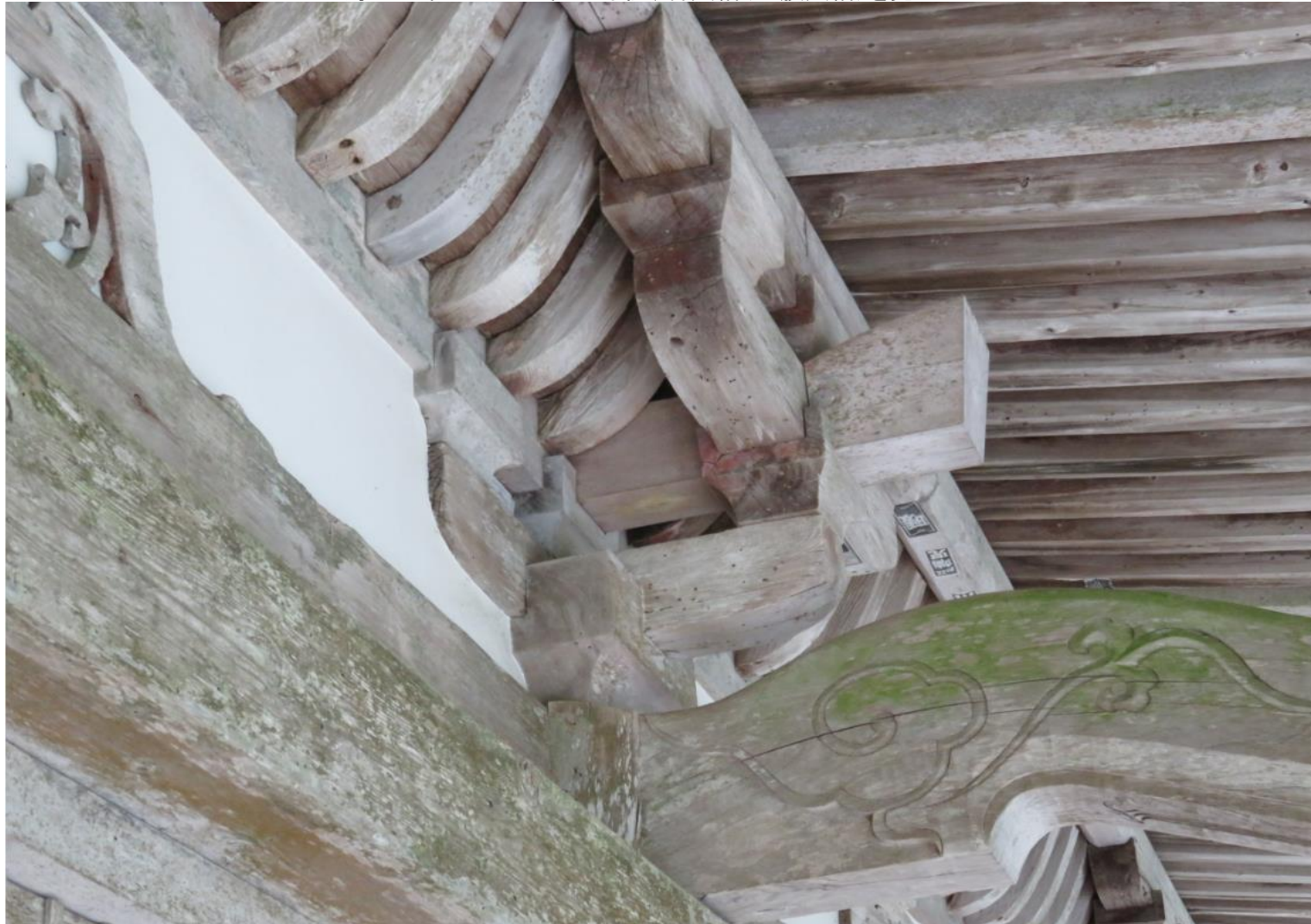
海老虹梁の上の出組の斗椽、軒支輪(蛇腹支輪)を見たところ
