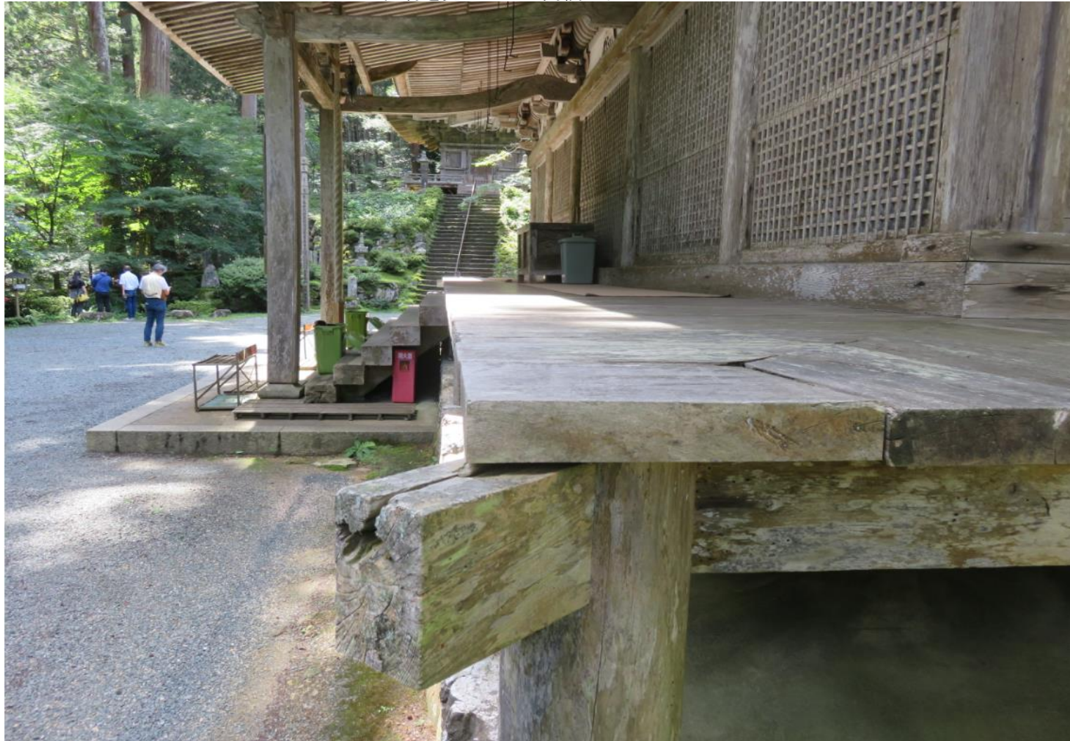
回縁を見たところ/高欄は付いていない
