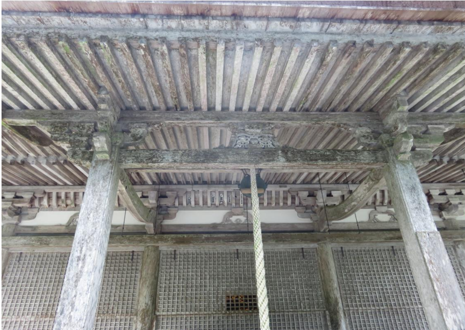
向拝の屋根裏を見上げたところ/正面の中備は墓股
