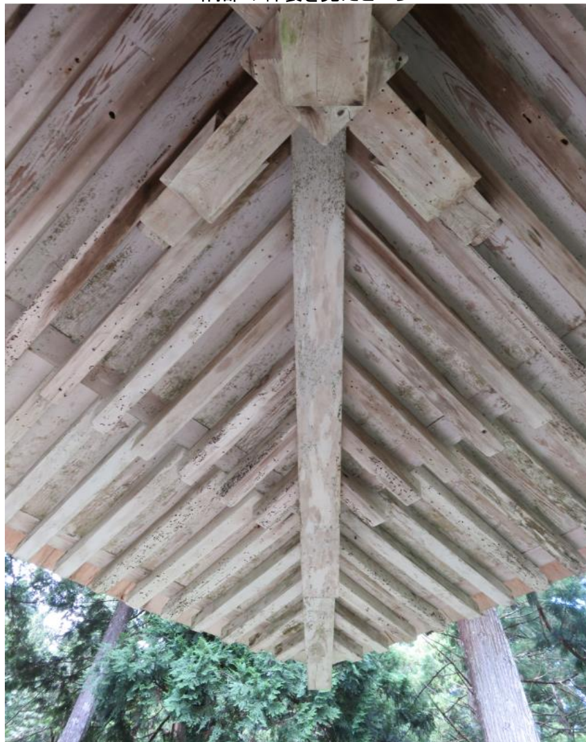
隅部の軒裏を見たところ
