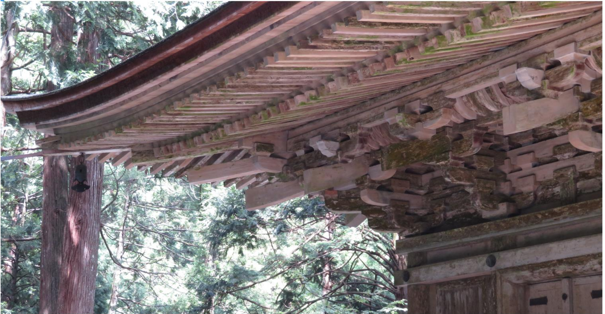
地垂木と飛檐垂木の軒下と、檜皮葺き屋根の軒反りを見たところ
