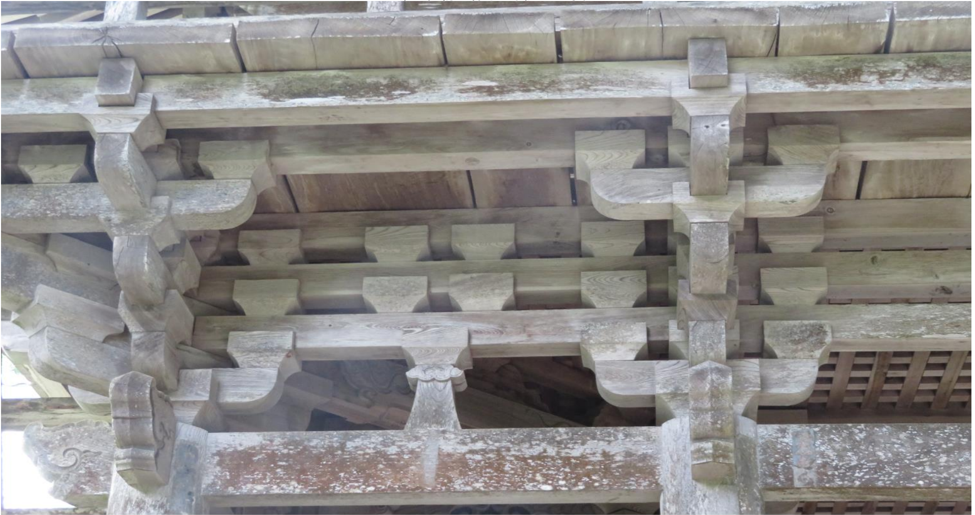
上部の組物の様子/斗拱は三手先
