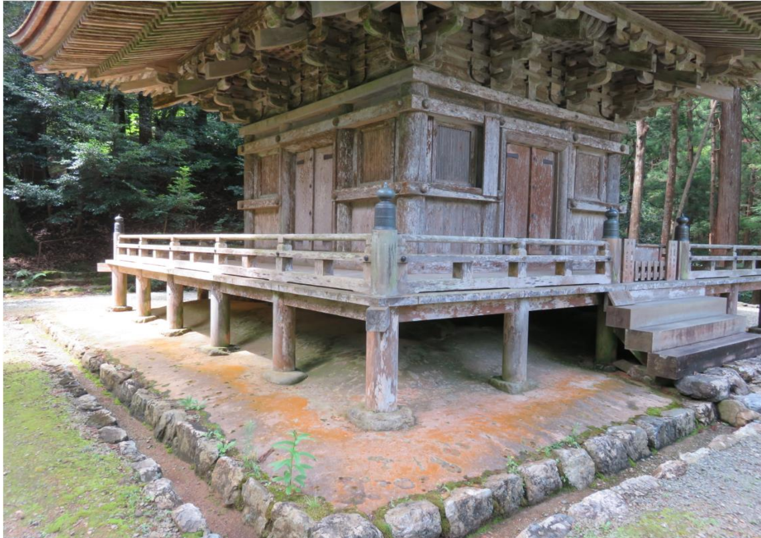
雨落溝が設けられている
