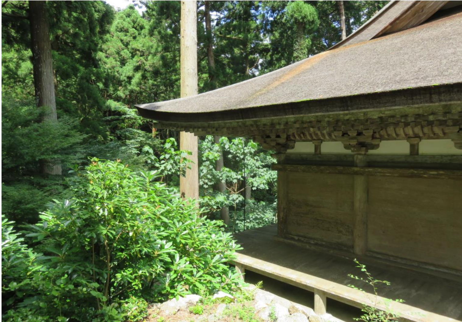
軒先左手を見たところ
