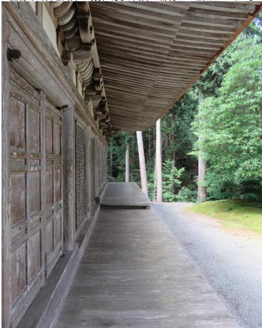
回縁は外陣と内陣の境界で奥の内陣の部分が一段上がっている
