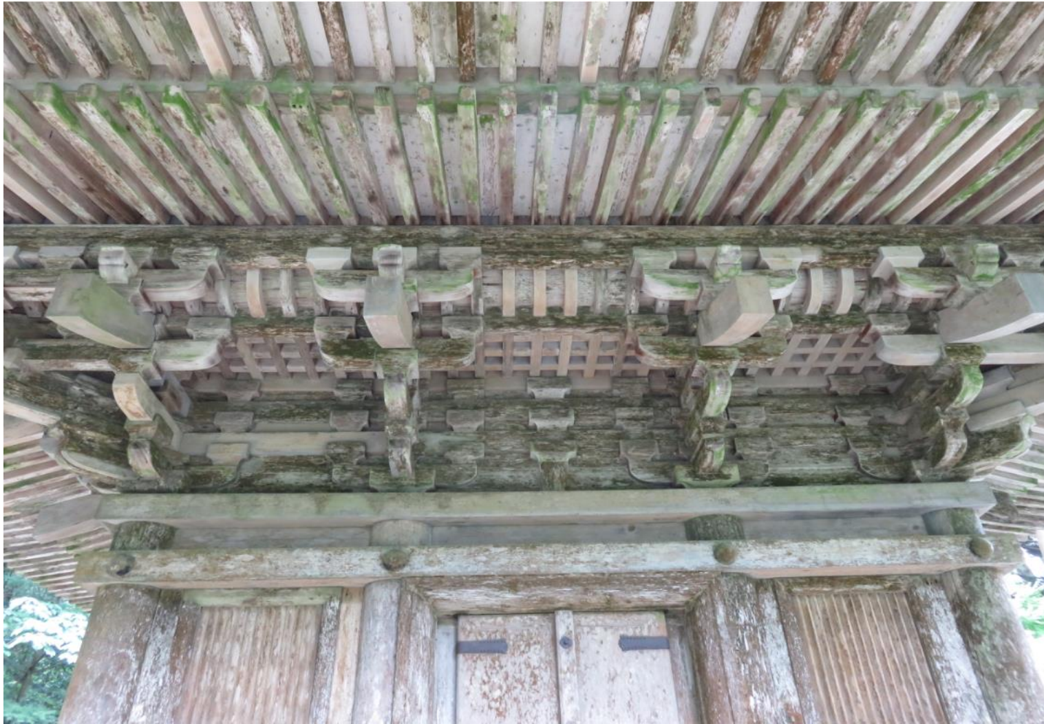
二軒/斗拱は三手先、中備は間斗束/軒天井(小天井)と軒支輪(蛇腹支輪)も見える
