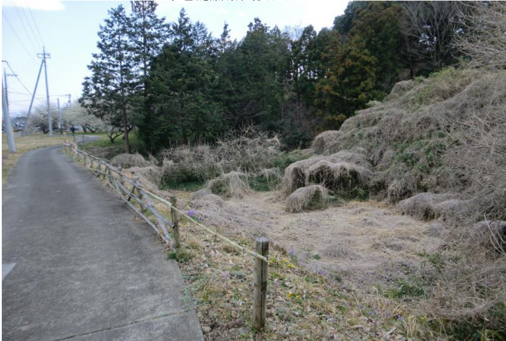
その空堀を南東方向に見たところ
