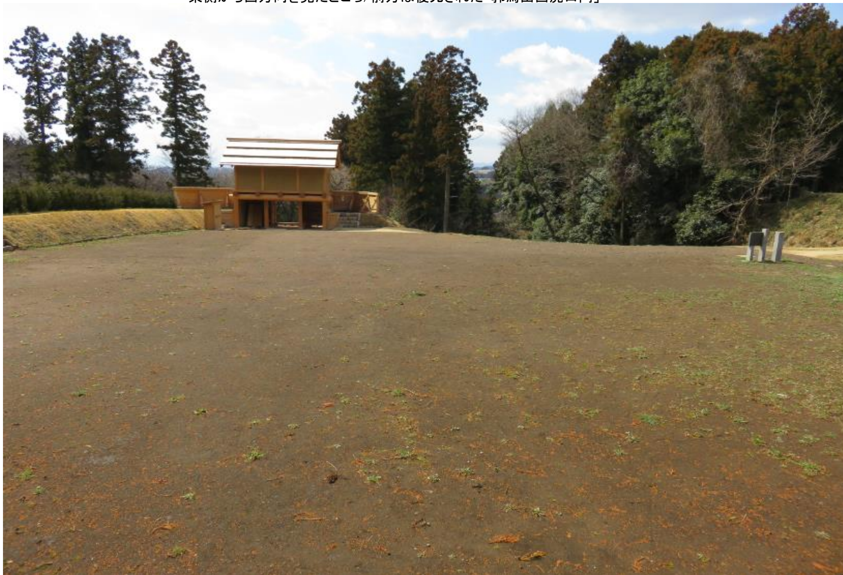
東側から西方向を見たところ/前方は復元された「郭馬出西虎口門」
