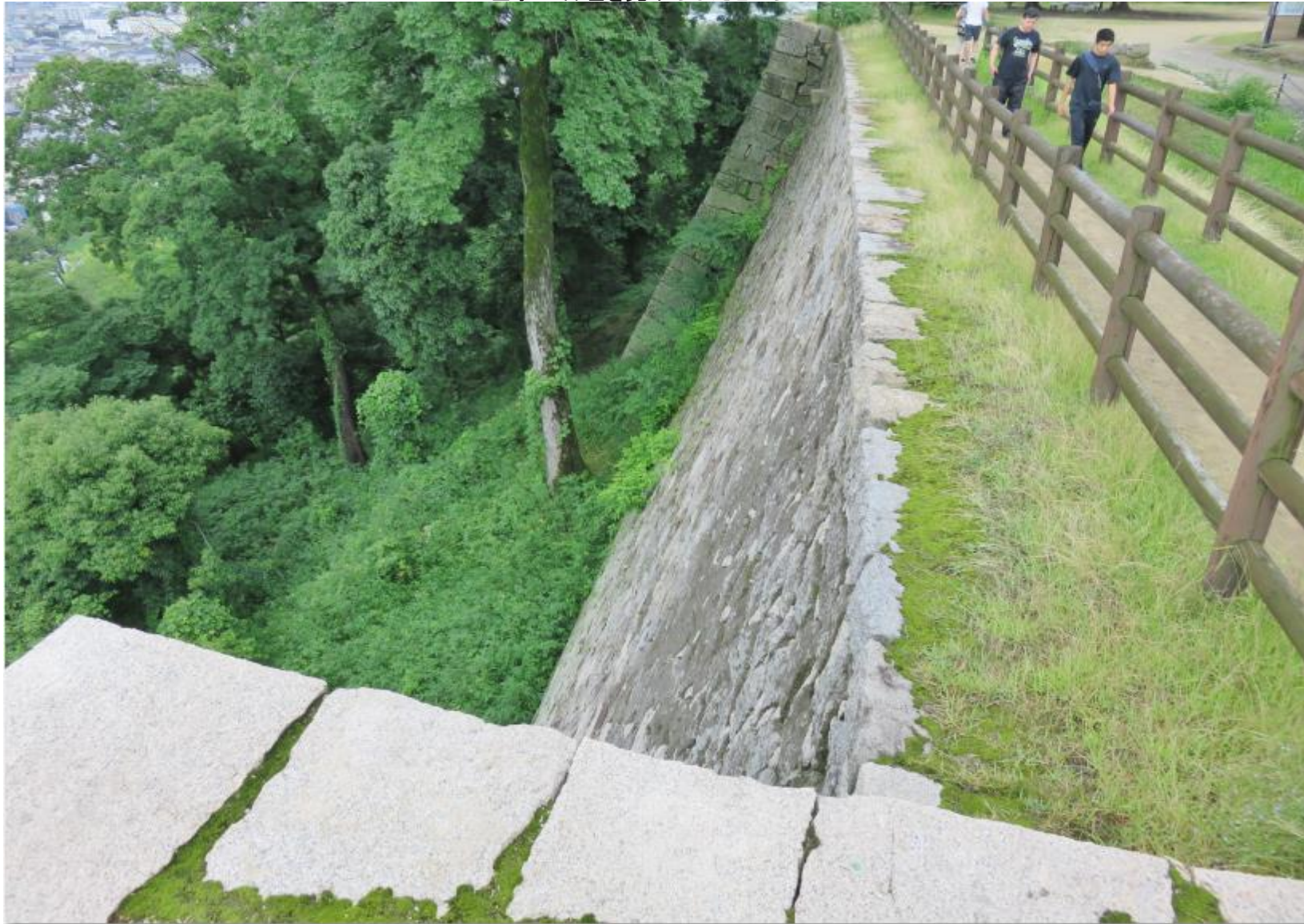
左手の石垣を見下ろしたところ
