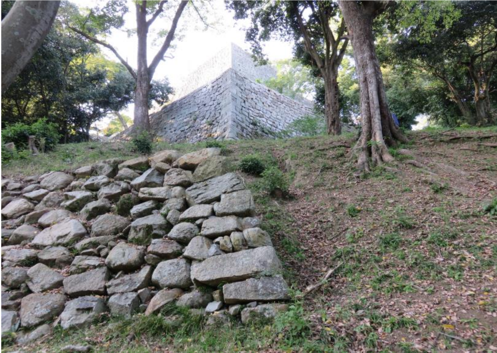
そこで上を見上げたところ/石垣が二段見える
