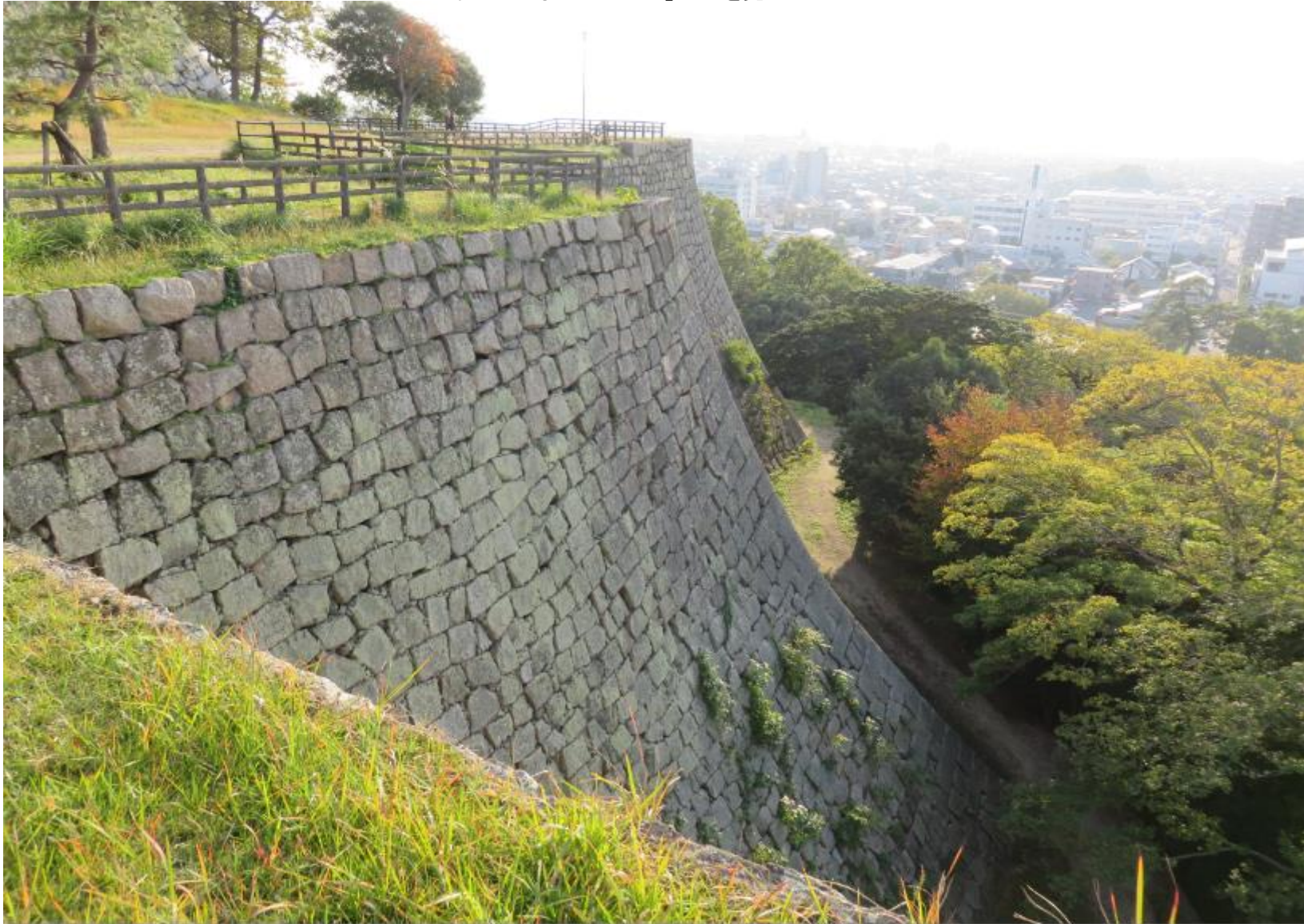
同じく左手の「三の丸」石垣を見たところ
