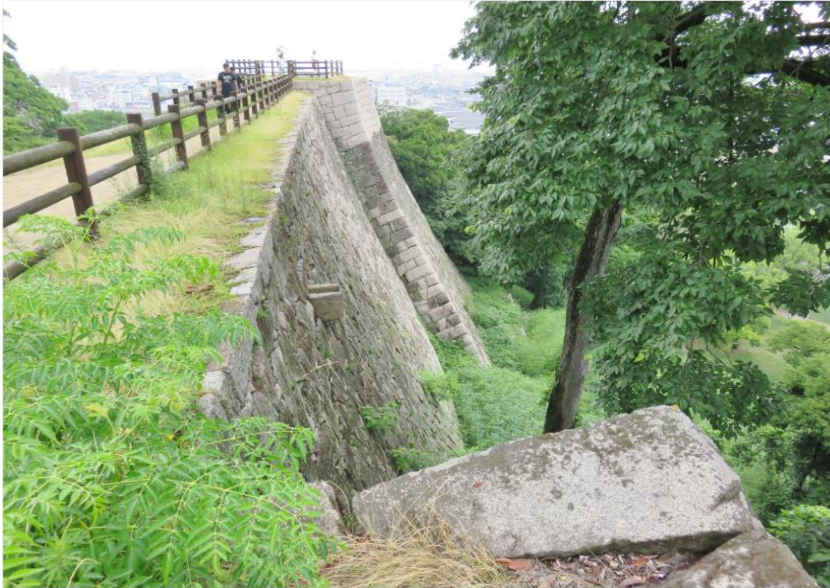
そこから振り返って石垣を見下ろしたところ/石垣面に雨水排水口がある
