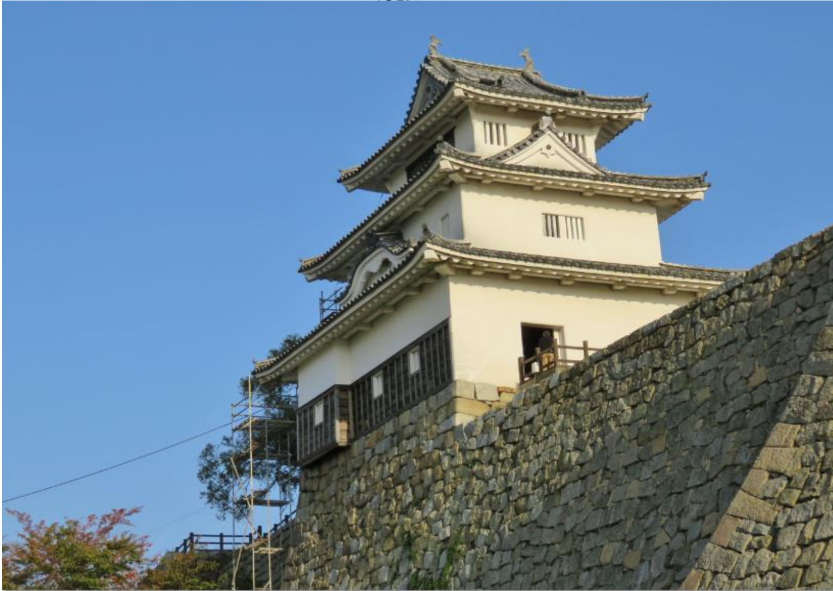
「天守」を見上げたところ
