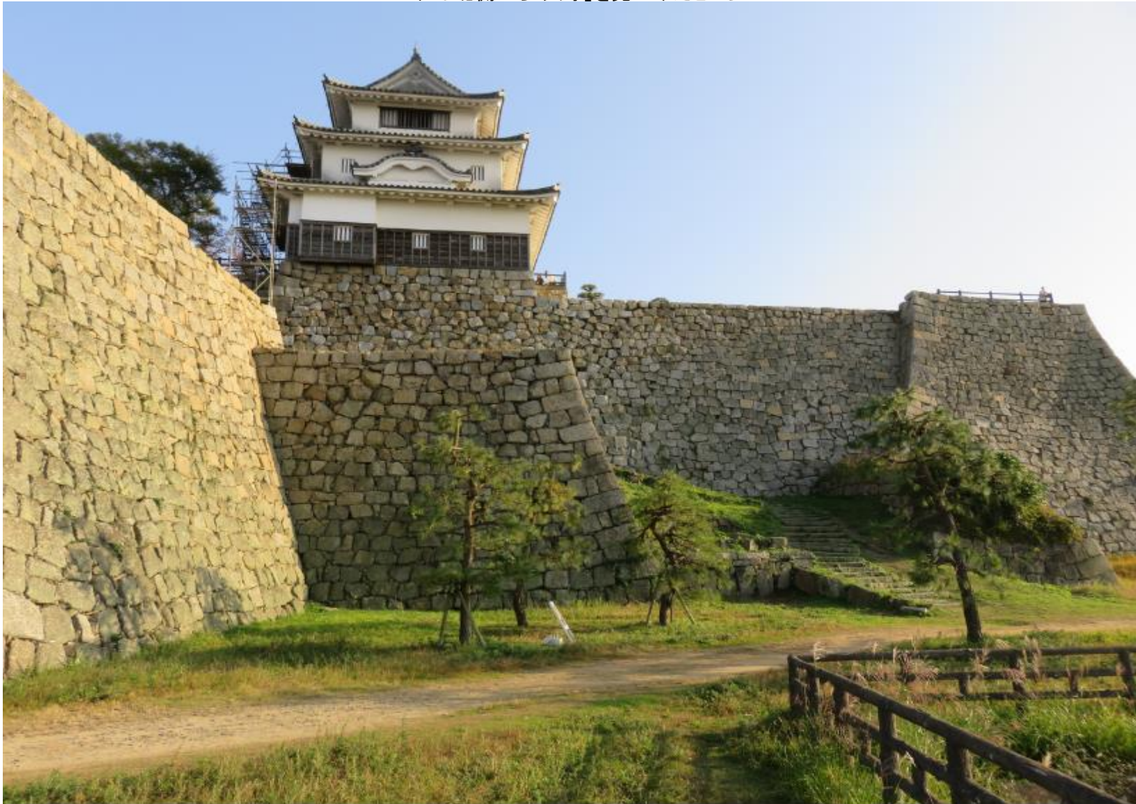
これは北側から「天守」を見上げたところ
