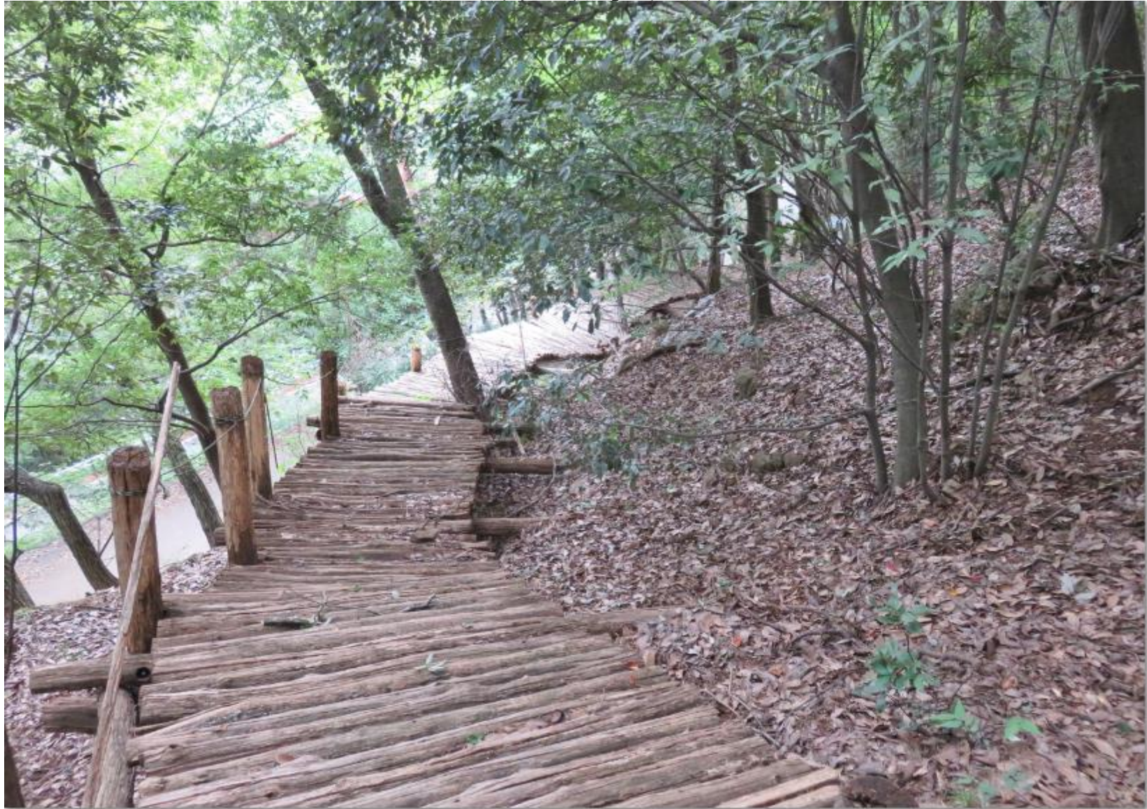
この先が先程見た「栈道」の始まり部分
