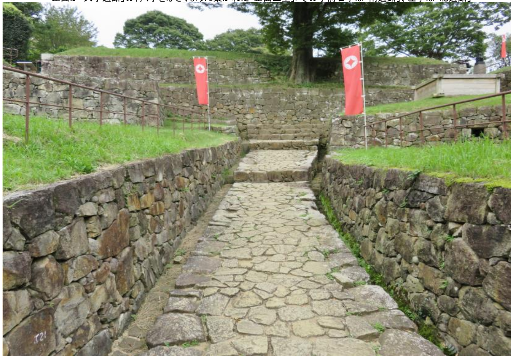
正面が「大手通路」の行く手をふさぐように築かれた「正面土塁」/その手前右手は「南通路」、左手は「北通路」
