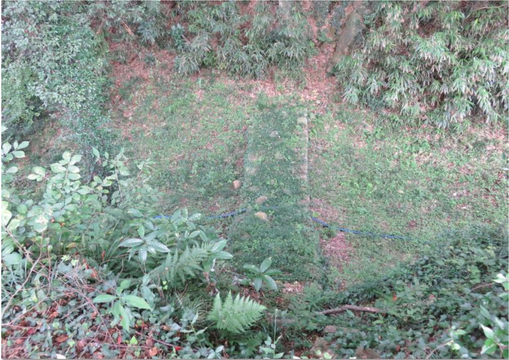
堀止の石積みが見られる
