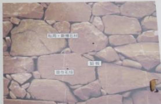
現存石垣と転用・新補石材の間に鉛板を入れ区別しています
