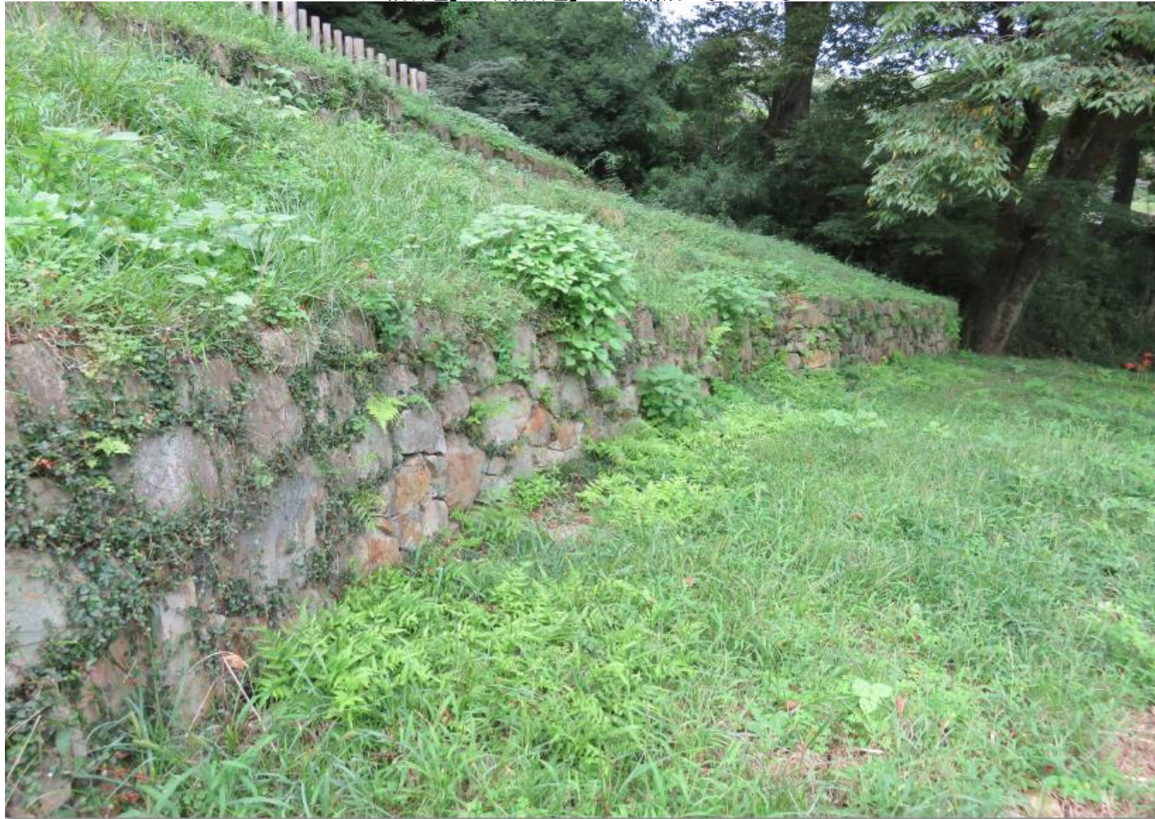
「上段石垣」と「下段石垣」の二段構成になっている
