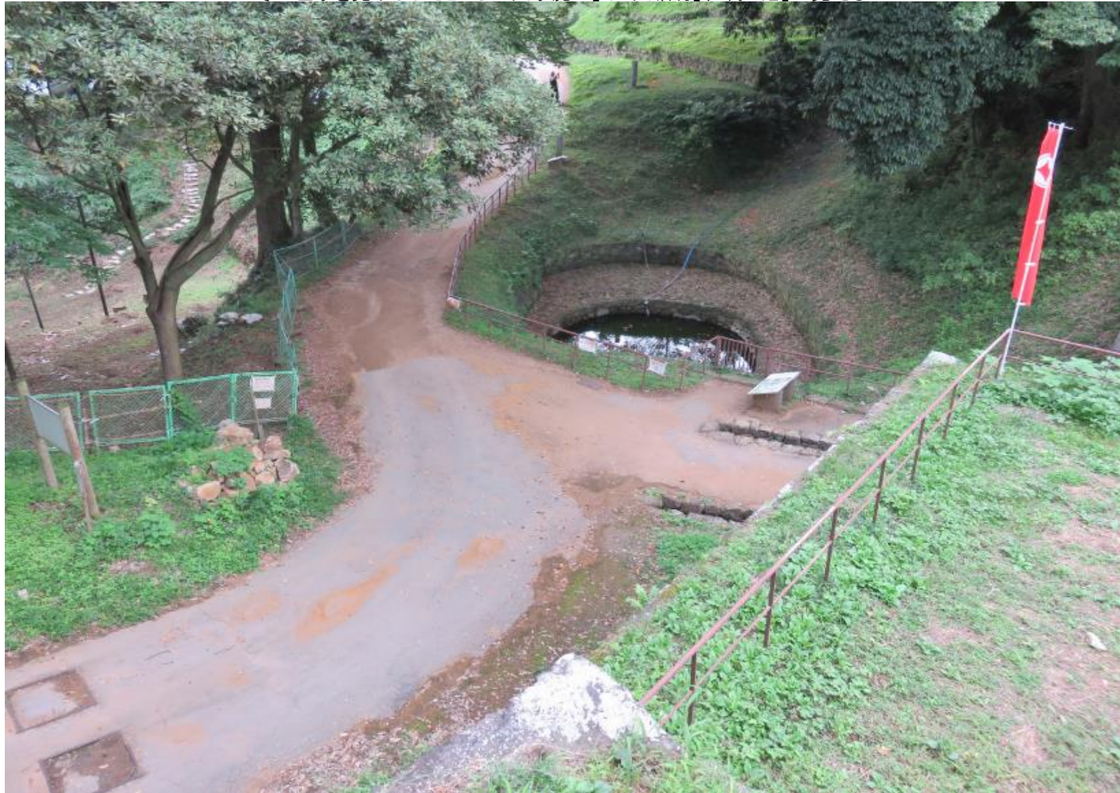
その左手を見下ろしたところ/「大手虎口」や「大堀切」、「月ノ池」が見える
