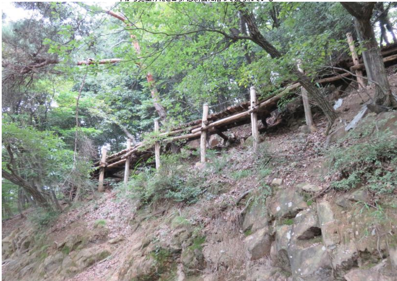
下から見上げたところ/急斜面に沿って造られている
