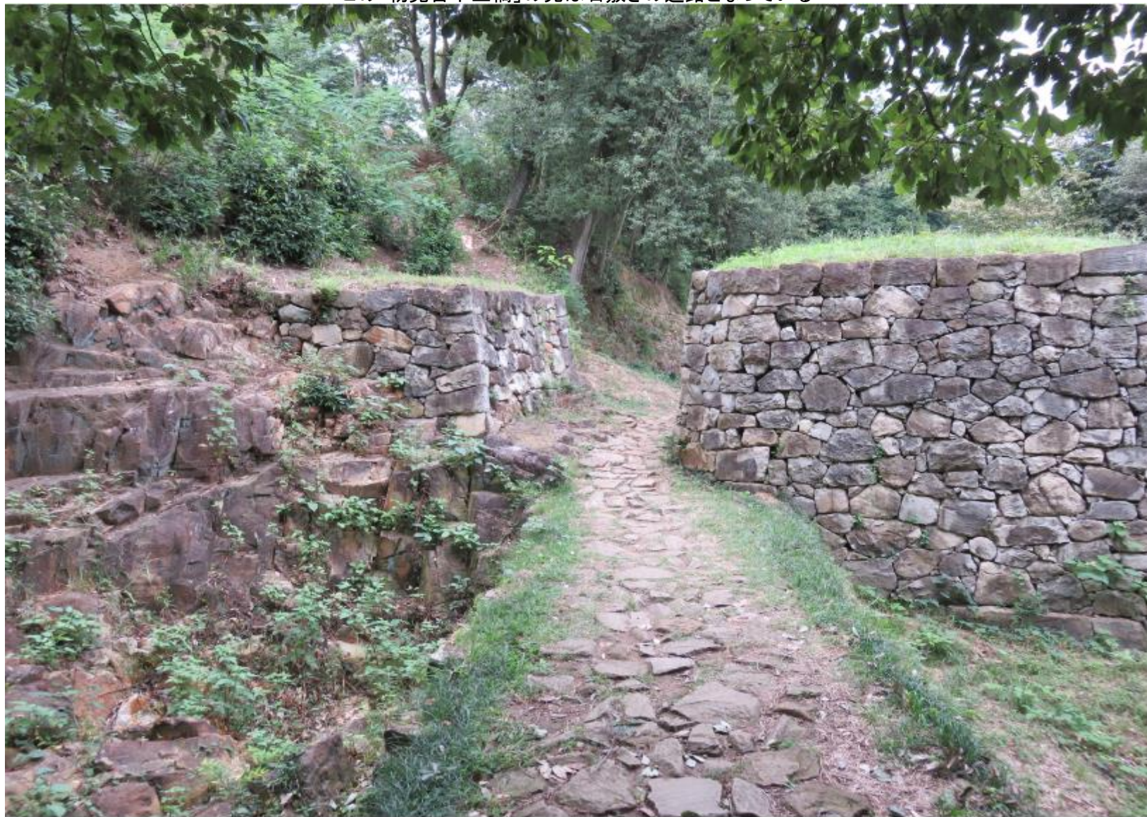
この「物見台下土橋」の先は石敷きの通路となっている
