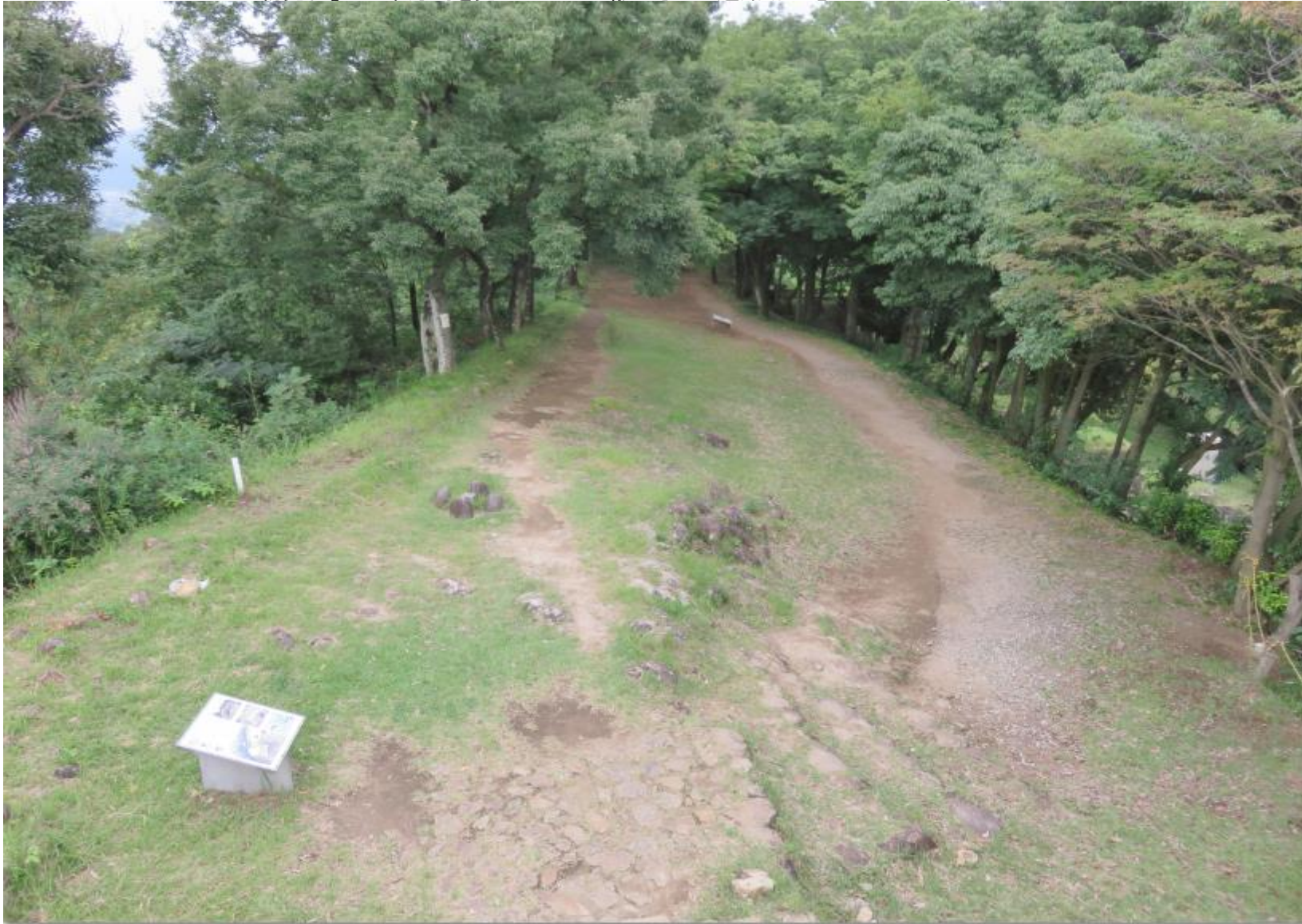
「物見台」から東方向を見たところ/石敷きされた通路跡の感じや石罫が見て取れる
