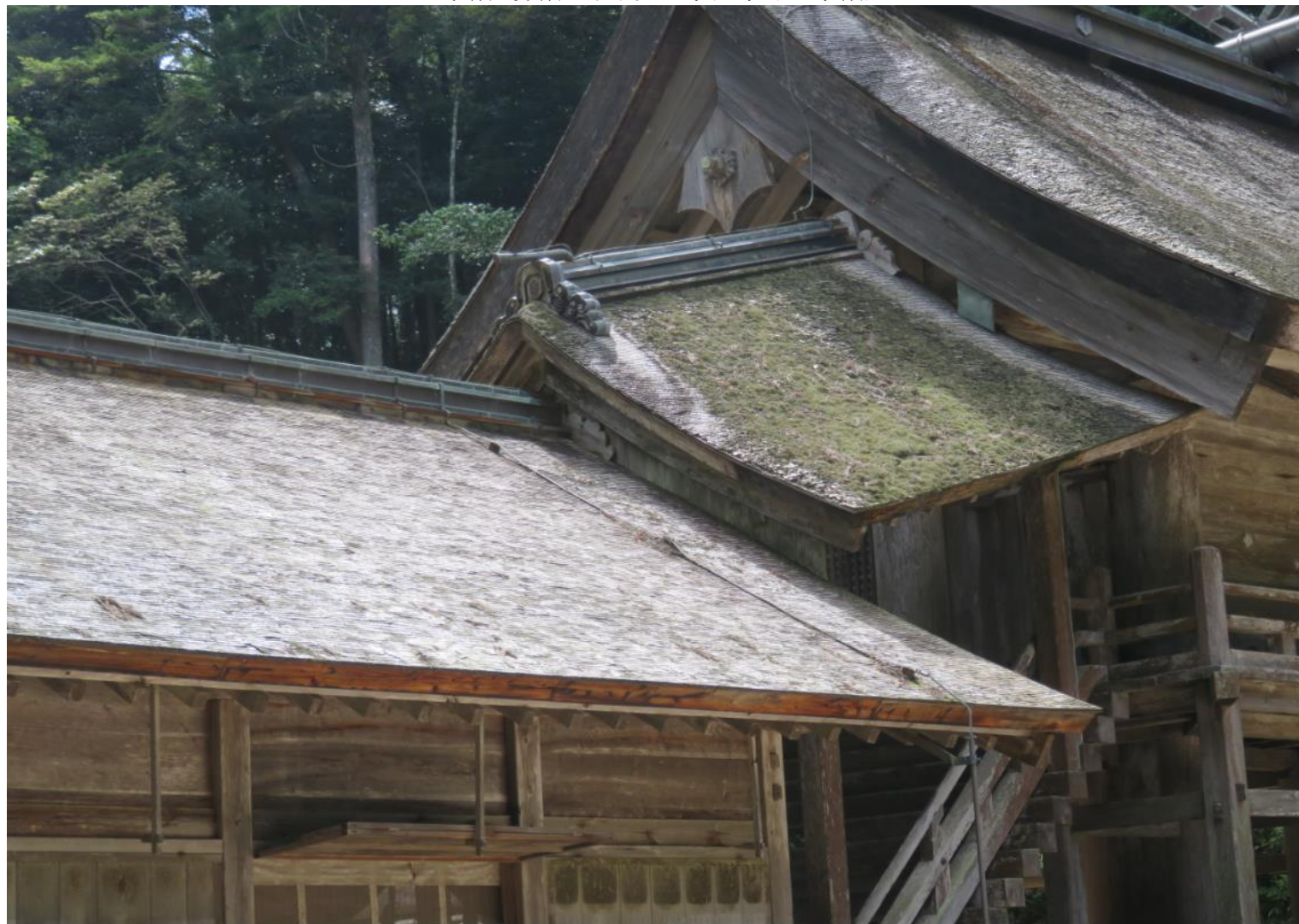
本殿と拝殿の取り合い部(いわゆる幣殿)
