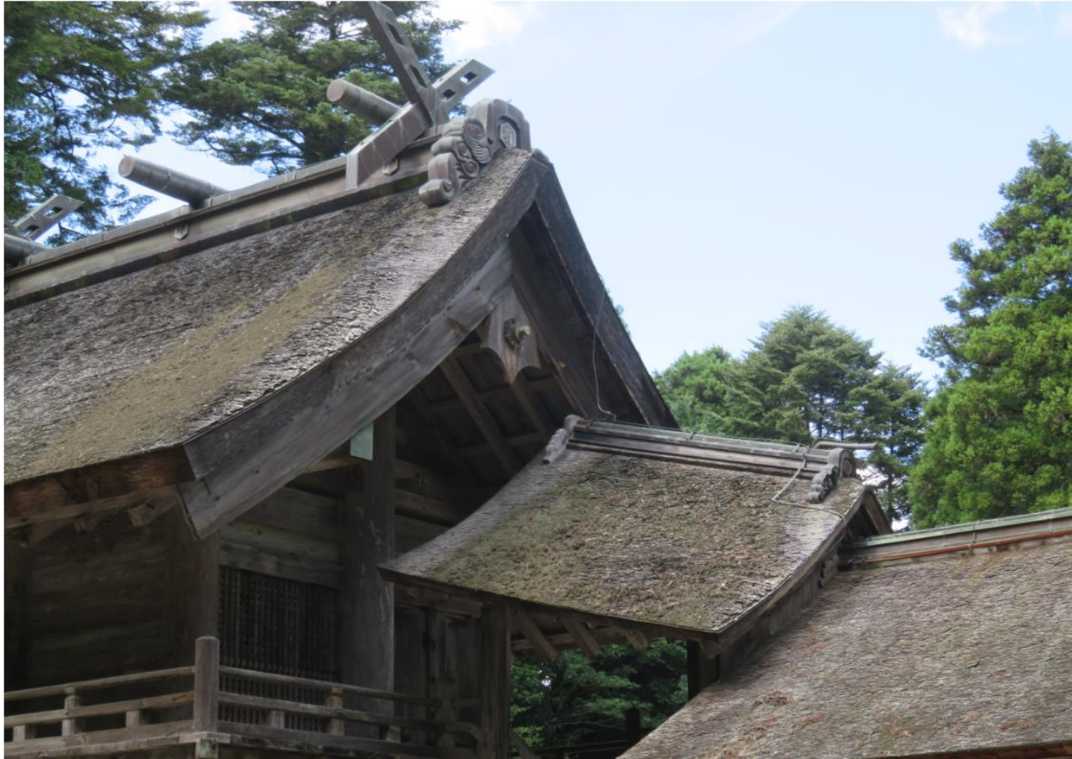
本殿と拝殿の取り合い部
