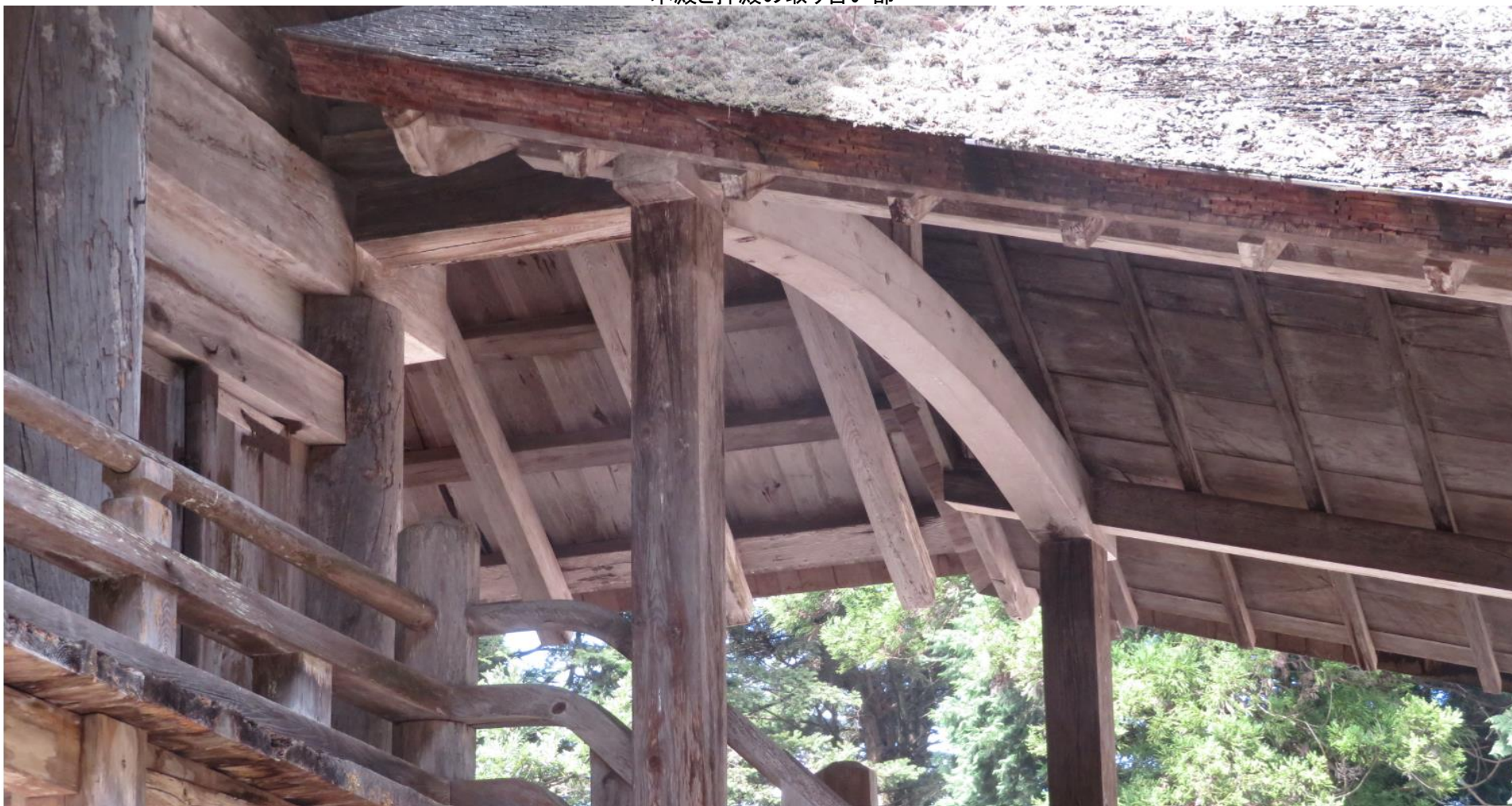
本殿と拝殿の取り合い部
