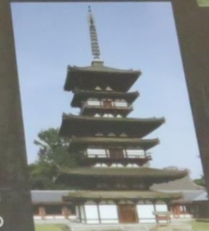
薬師寺東塔 (建塔年代: 天平2(730)年) (写真: 飛鳥園)
