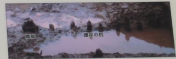
橋脚と護岸の杭
