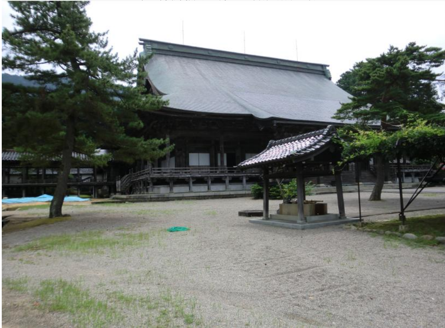
本堂/南砺市指定文化財/1885年再建(明治18年)
