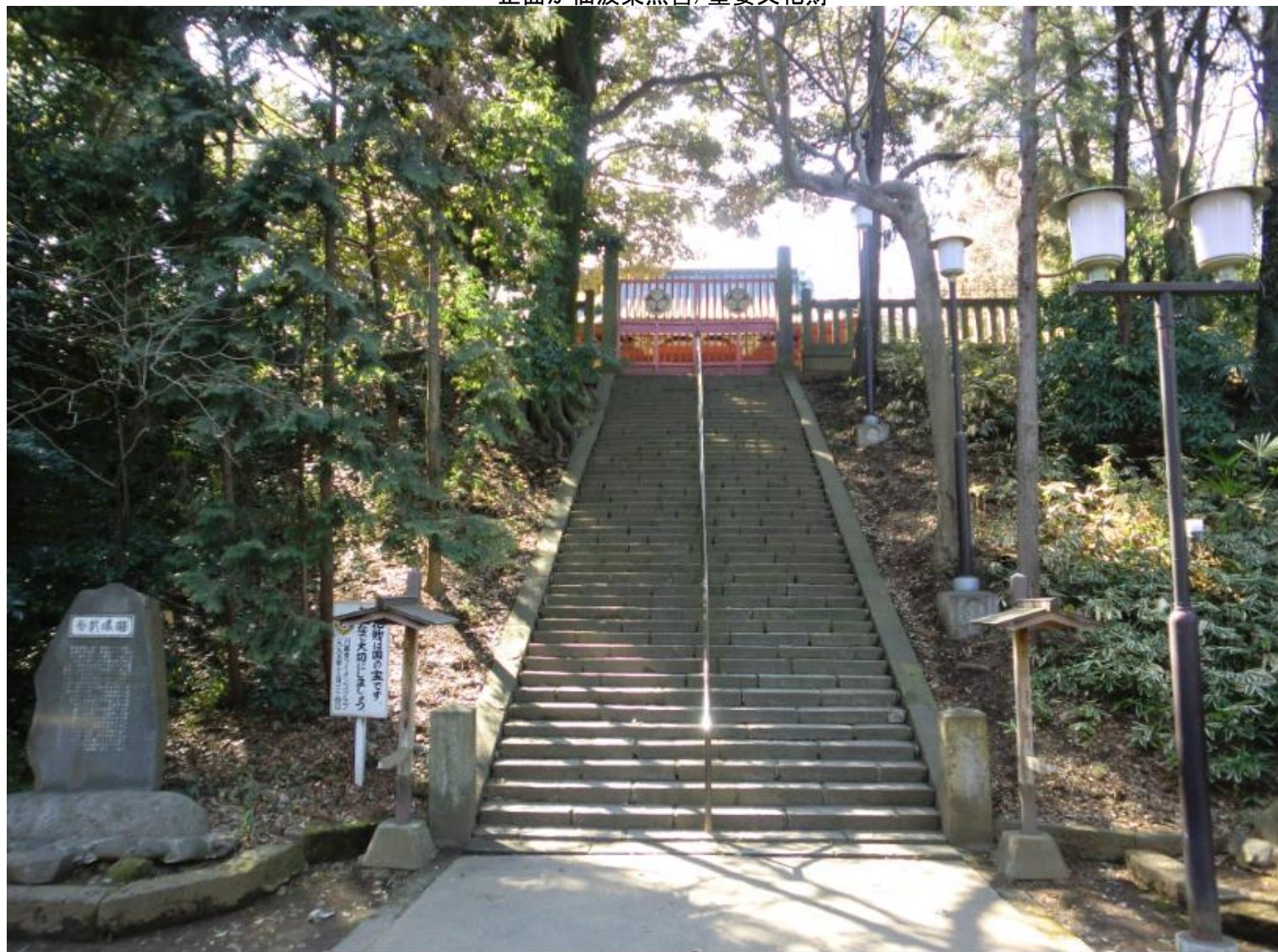
正面が仙波東照宮/重要文化財
