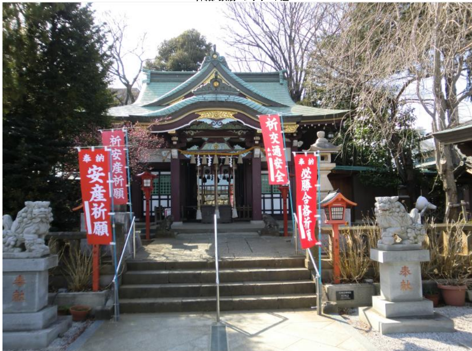
拝殿/鉄筋コンクリート造
