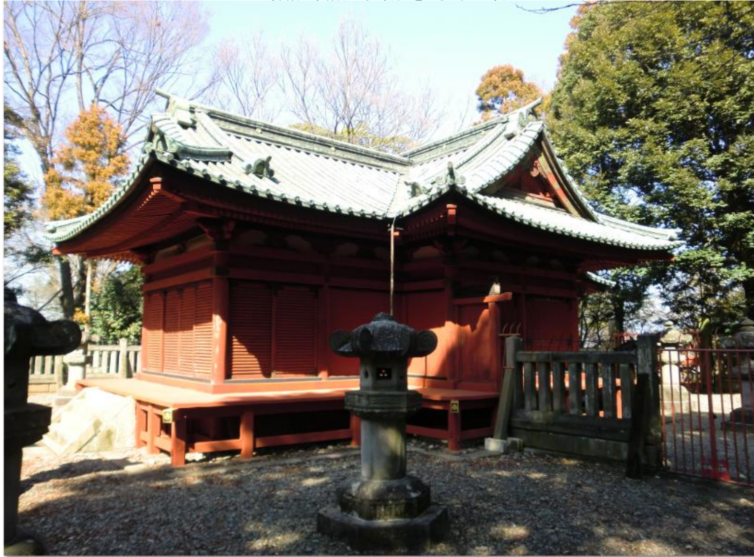
拝殿と幣殿(左手部分)を左後方から見る
