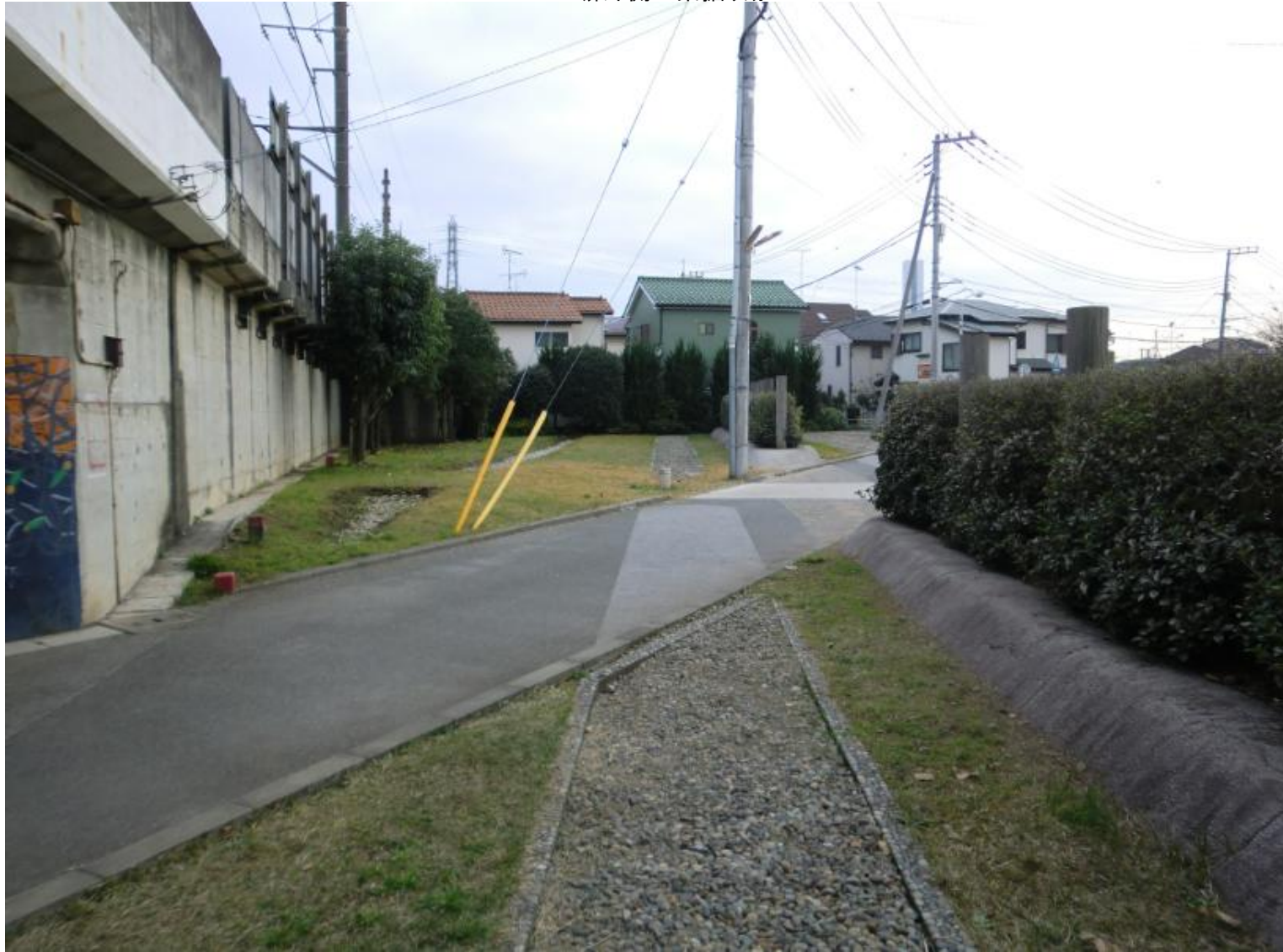
塀外側の素掘り跡
