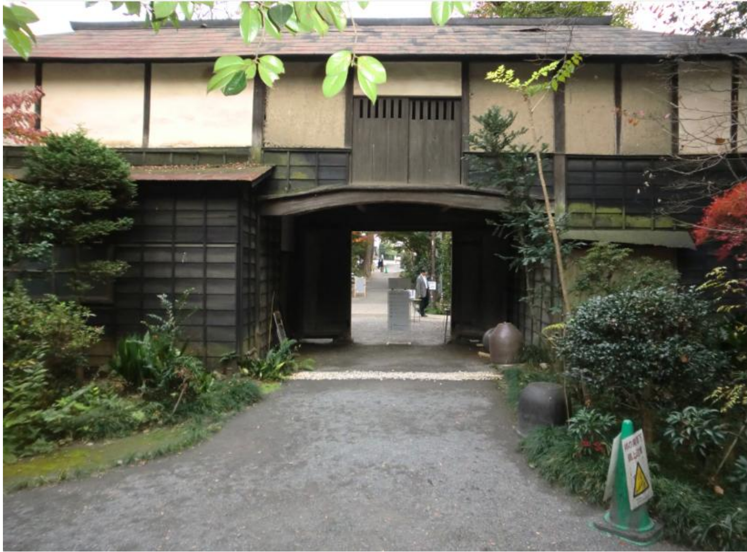
長屋門を庭園内から見る
