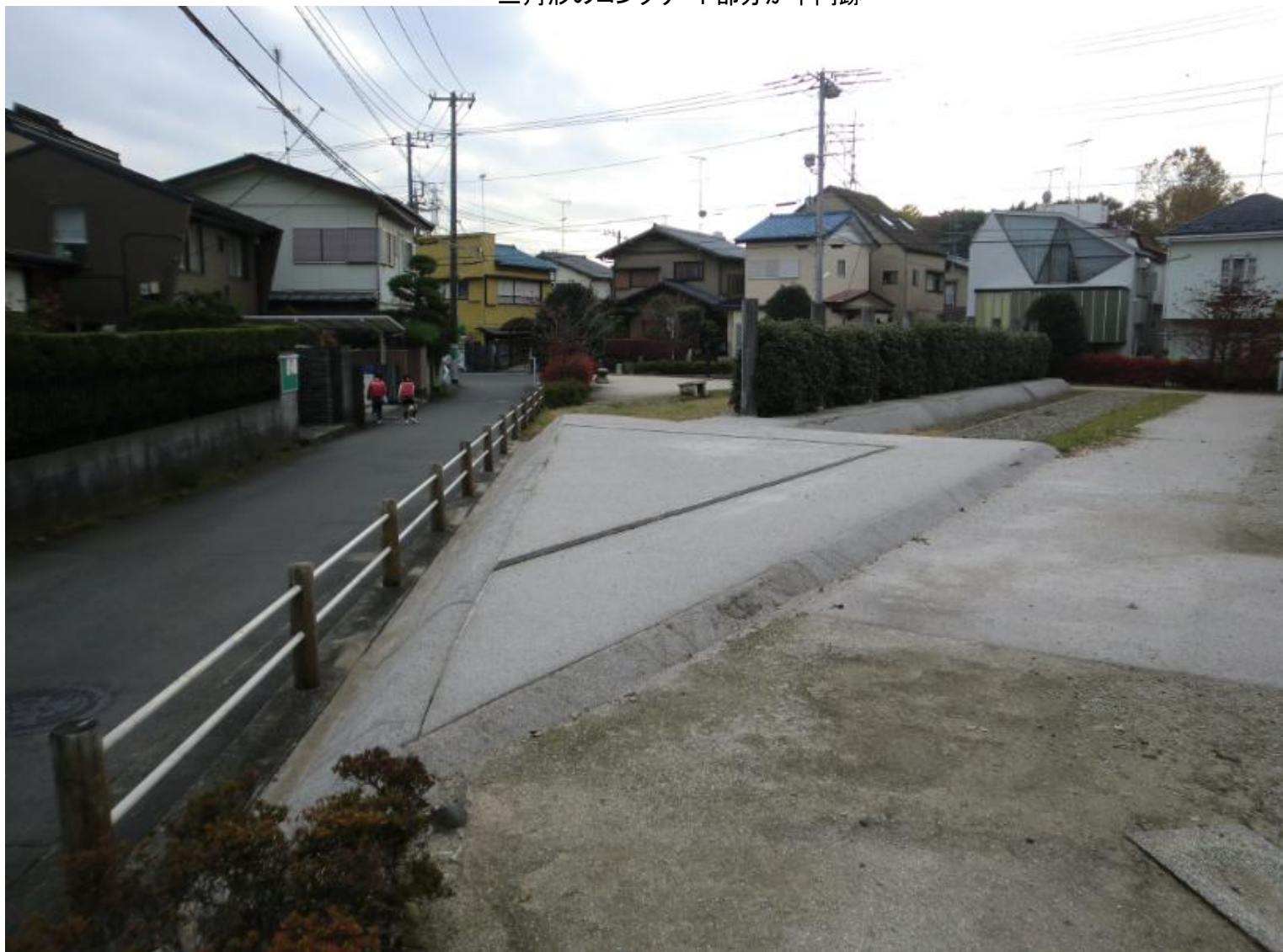
三角形のコンクリート部分が中門跡
