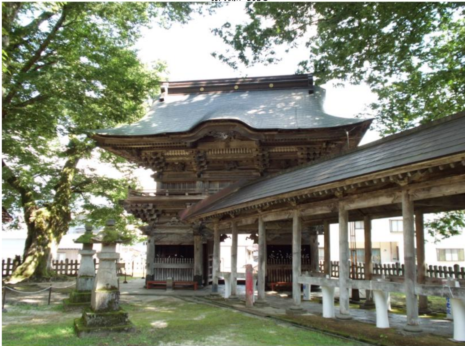
境内側から見る
