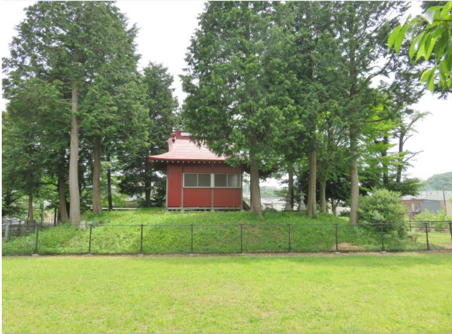
北側から見たところ
