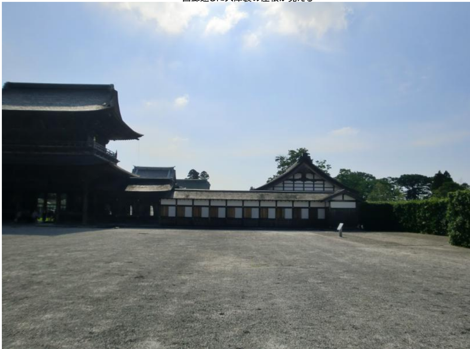
回廊越しに大庫裏の屋根が見える
