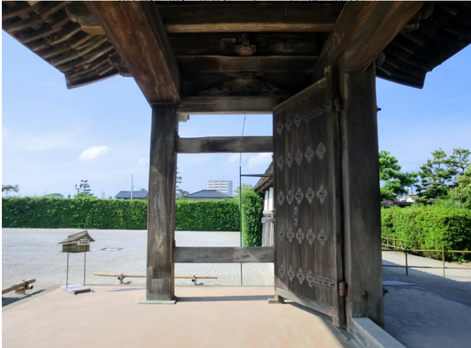
薬医門（やくいもん） - 鏡柱から控え柱までを取り込む屋根を持つ。本来は公家や武家屋敷の正門などに用いられたが、扉をなくして医家の門として用いられたのでこの名前がある。（ウィキペディアより）
