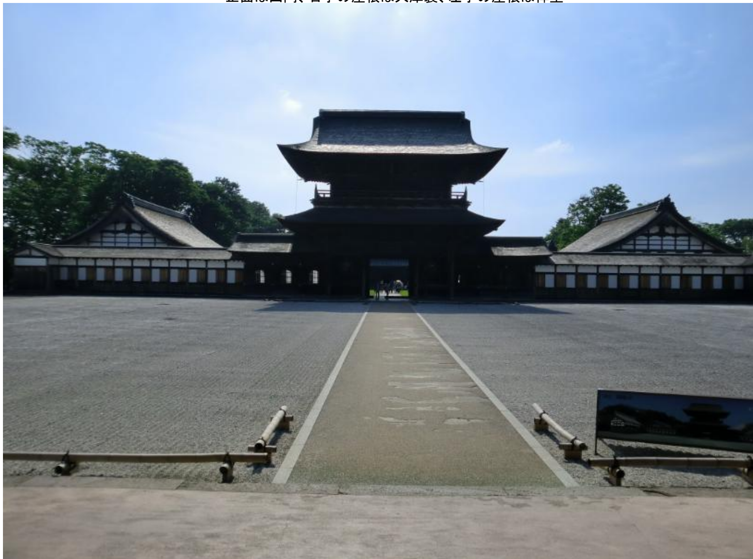
正面は山門、右手の屋根は大庫裏、左手の屋根は禅堂
