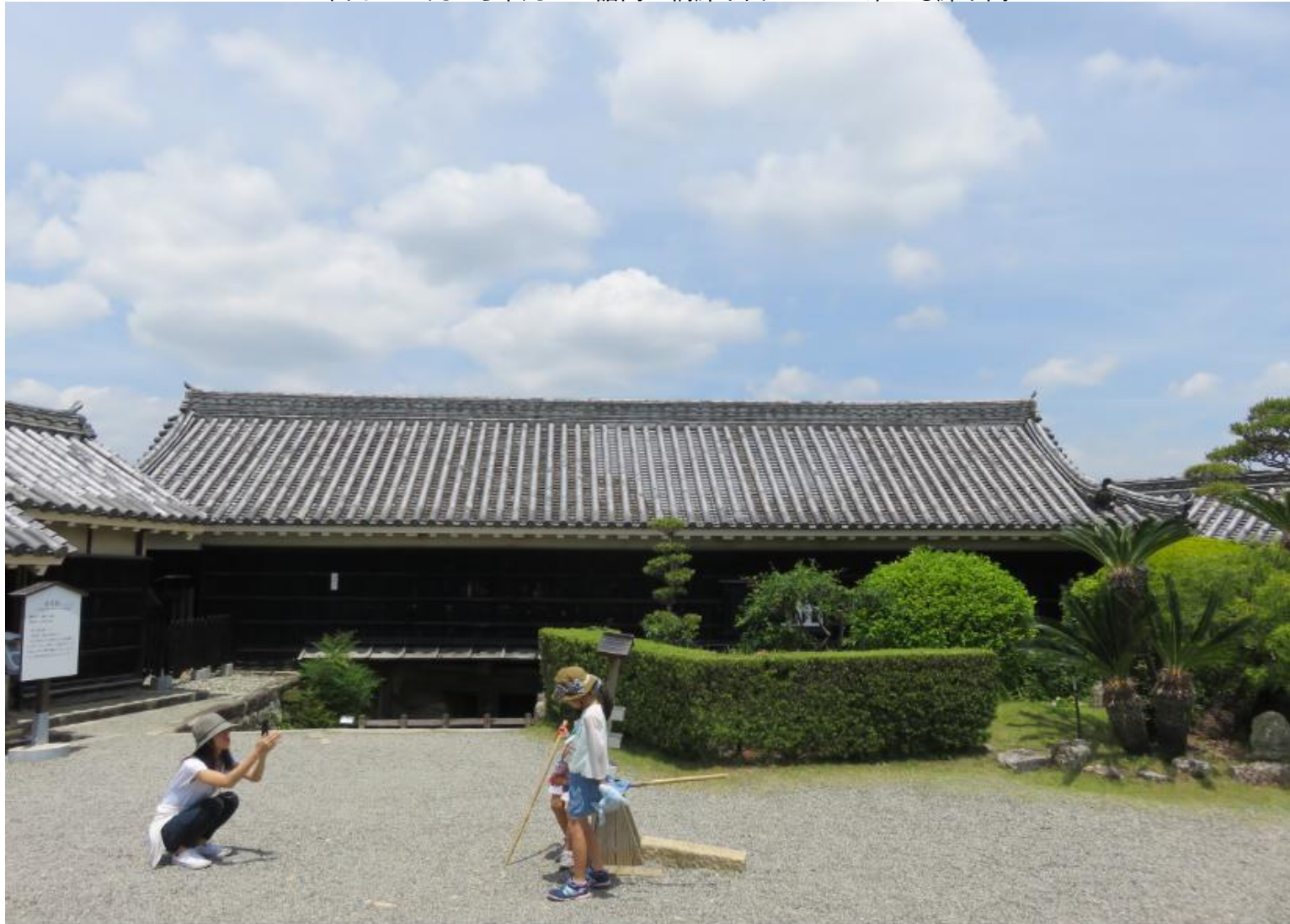
正面は二の丸から本丸への詰門の橋廊下出口の上に架かる廊下門
