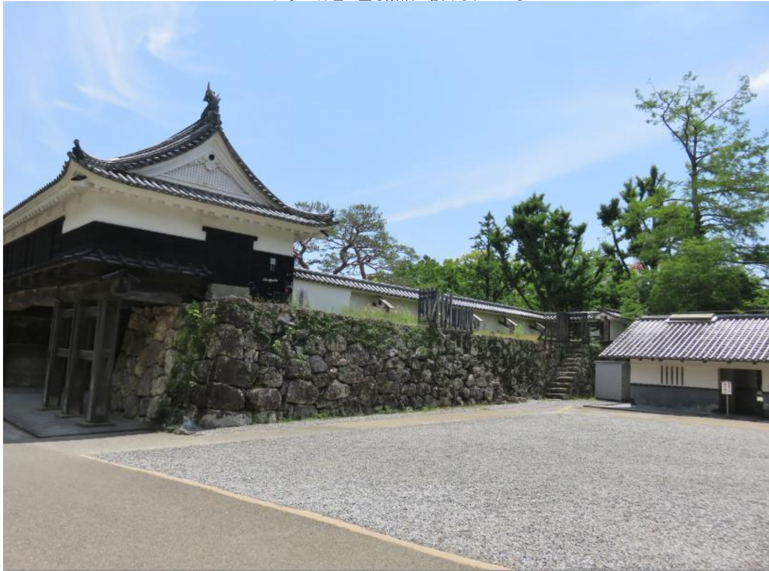
右手に石垣に登る階段が設けられている
