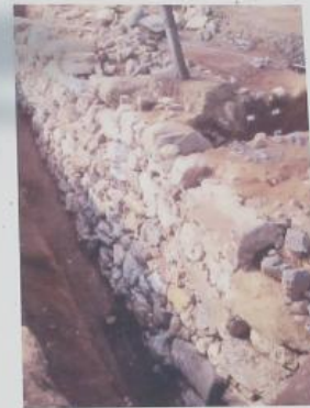
小ぶりの自然石を利用して積み上げられている
