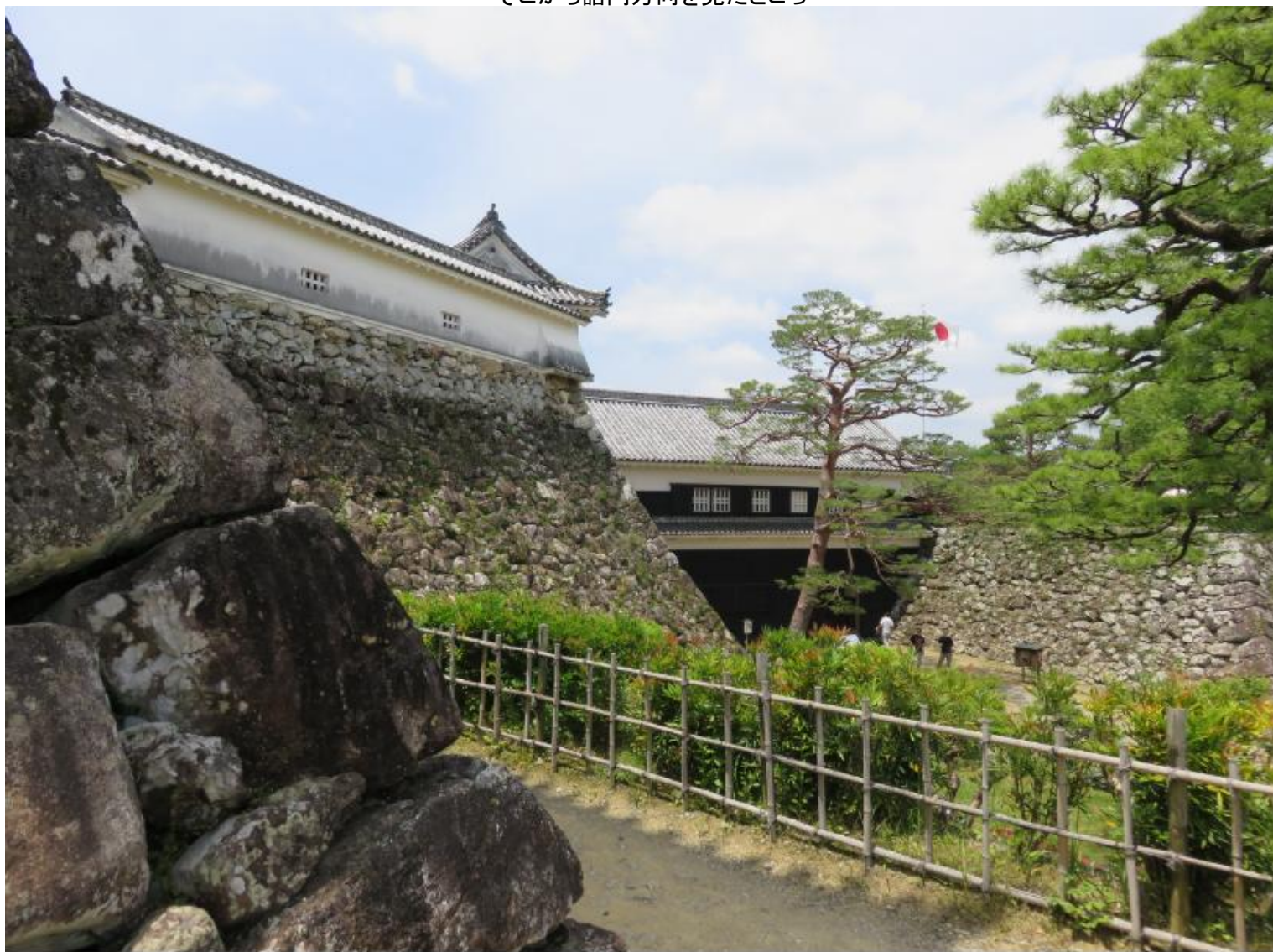
そこから詰門方向を見たところ
