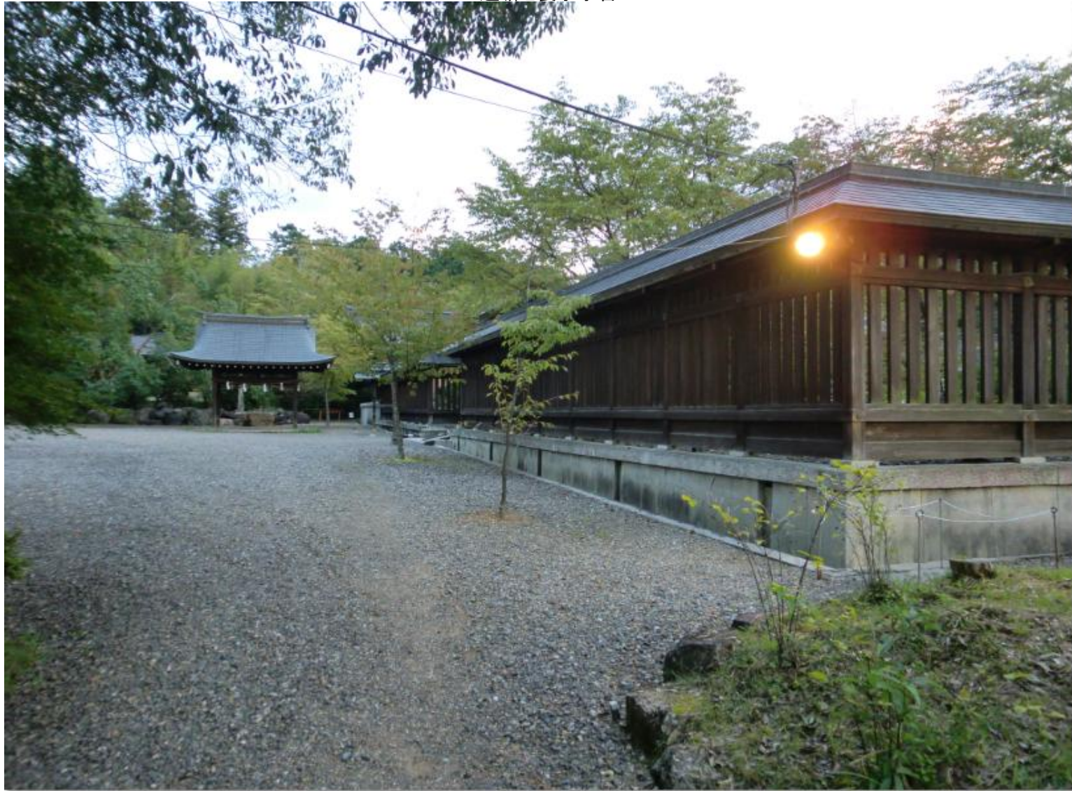
透塀と裏手水舎
