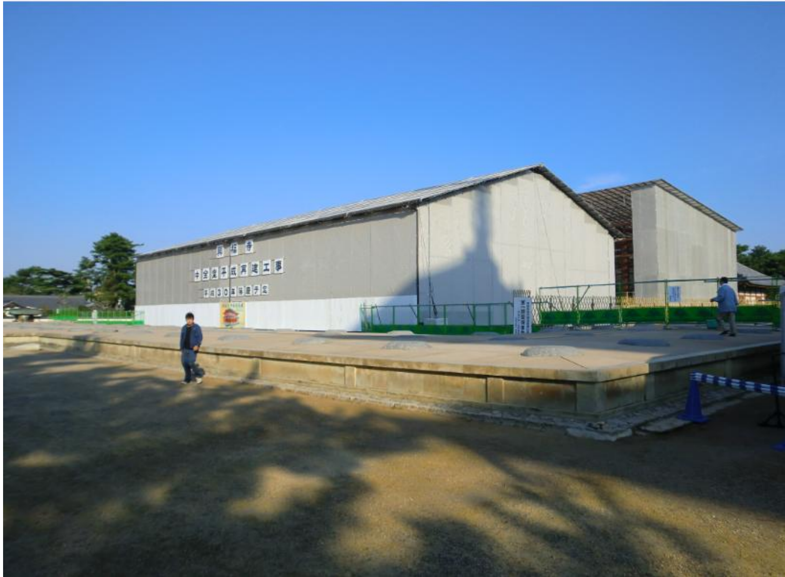
中金堂再建現場
