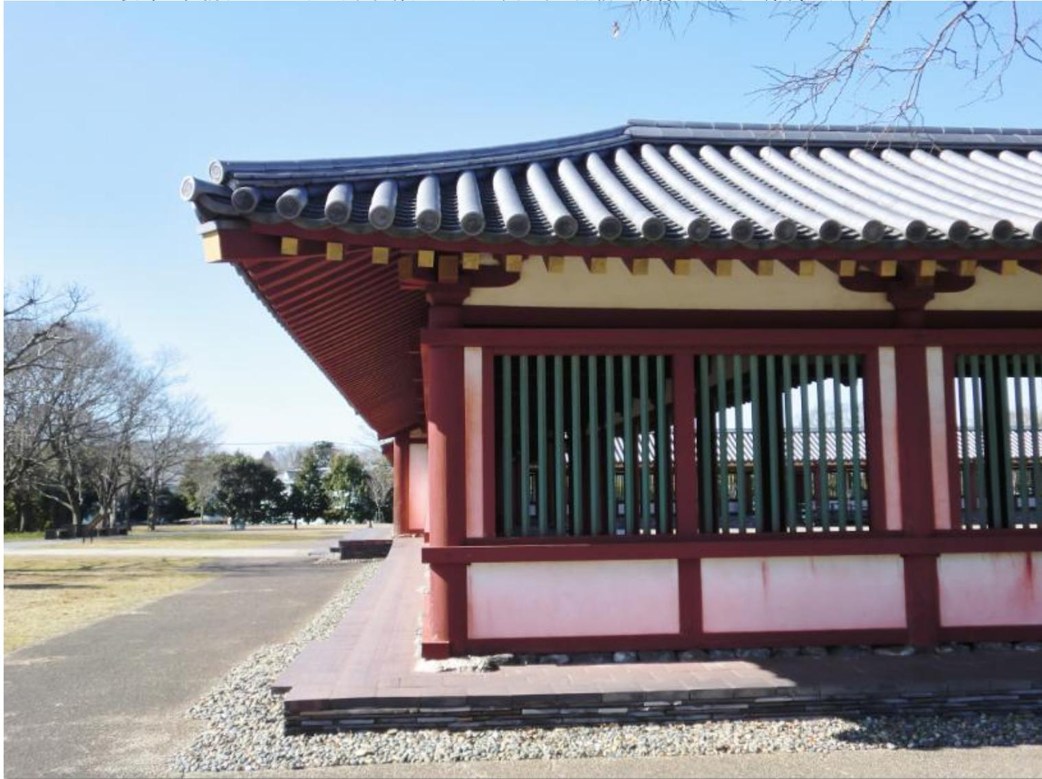
反った軒に対して軸部を調和させるため、隅柱を他の柱よりほんの少し高くする手法(隅柱の伸び、生起/中国)を使おうとしたのか？
