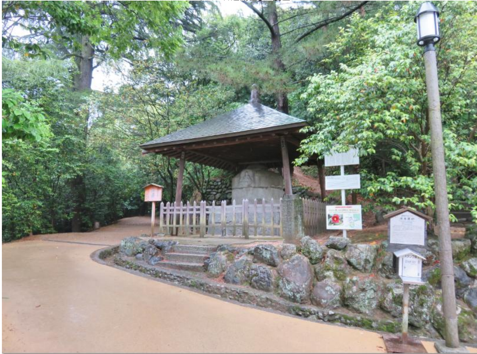
これは「石造湯釜」の覆屋
