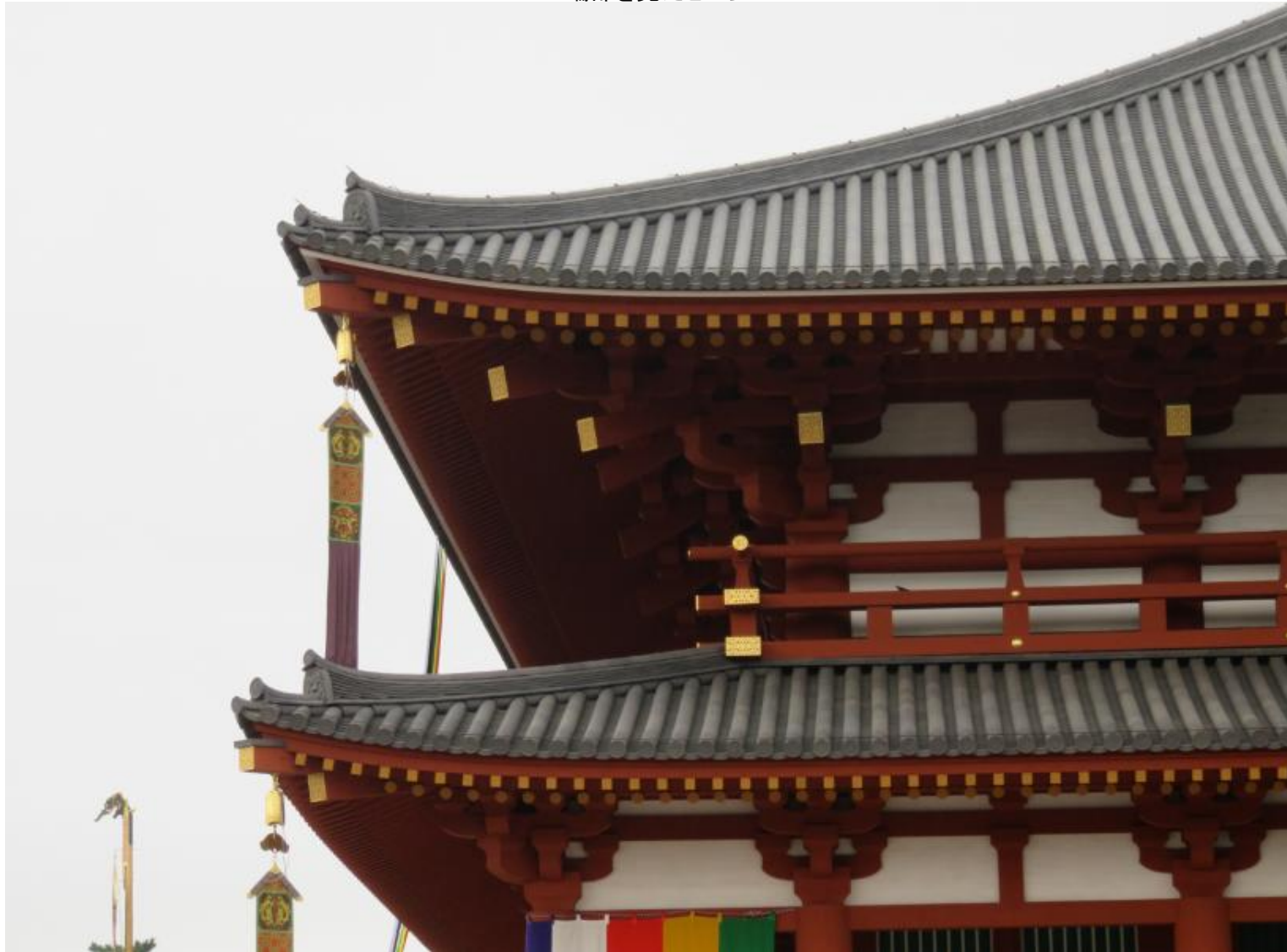
端部を見たところ
