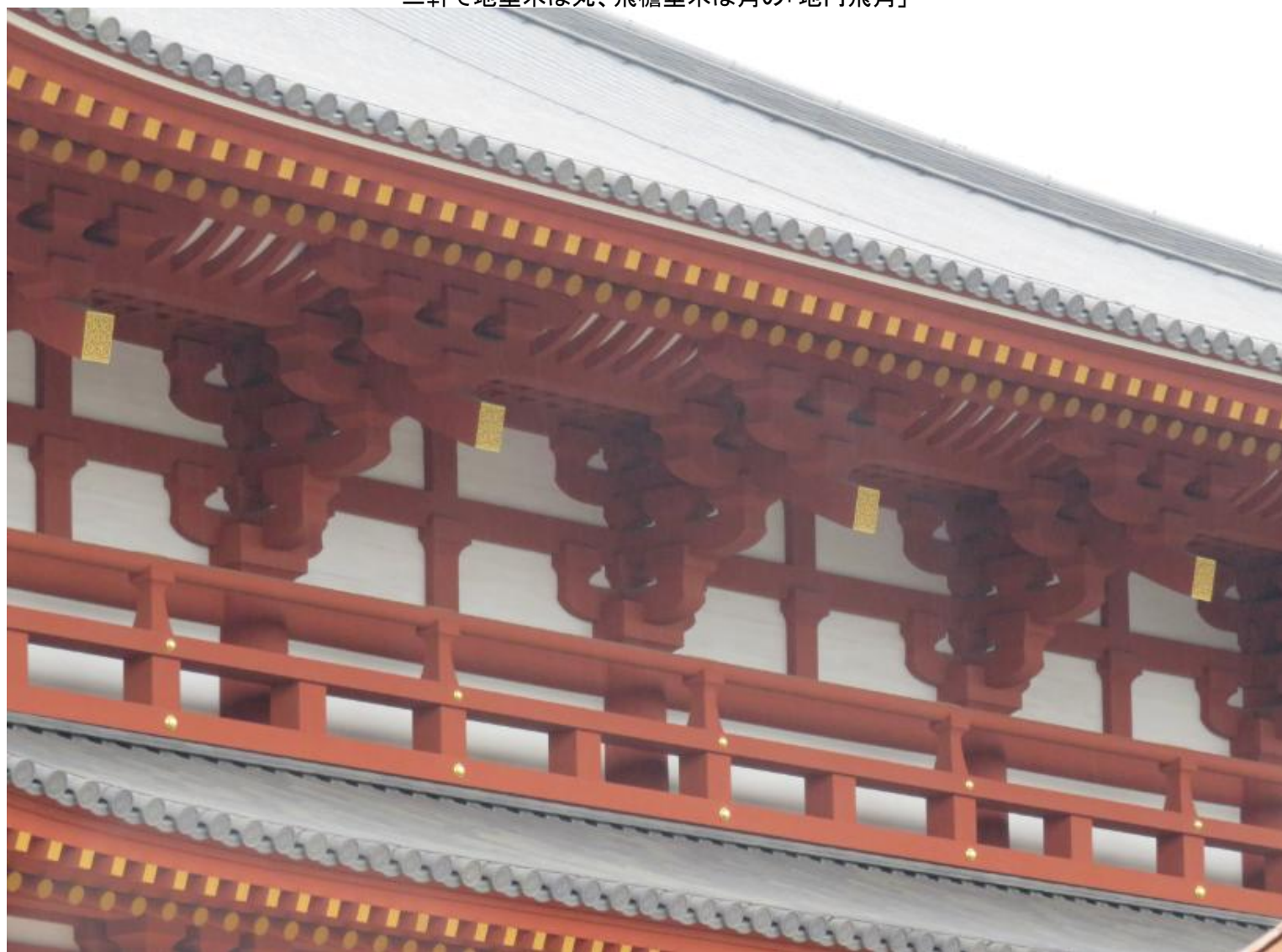
二軒で地垂木は丸、飛檐垂木は角の「地円飛角」
