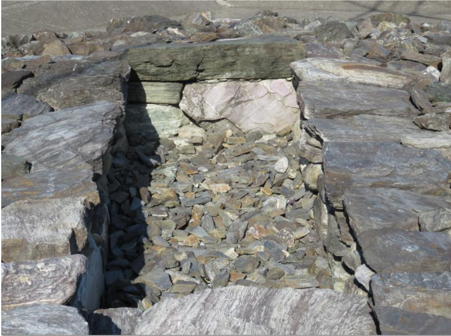
奥の玄室部分をアップで見たところ
