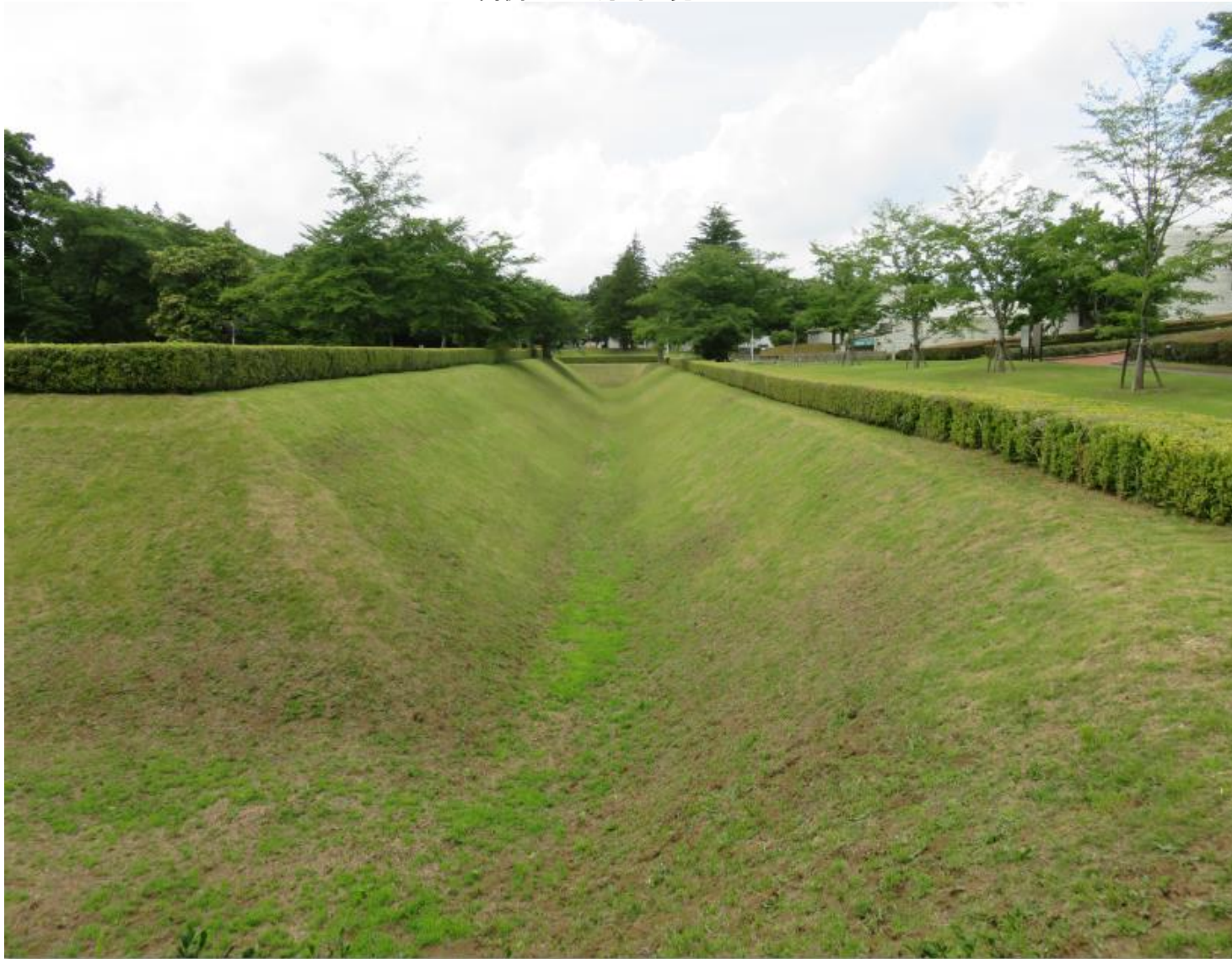
南側から北方向に見たところ
