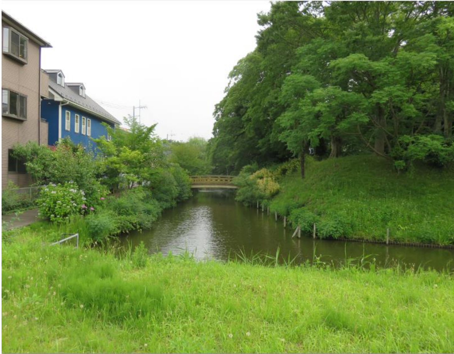
その木橋を北東側から見たところ
