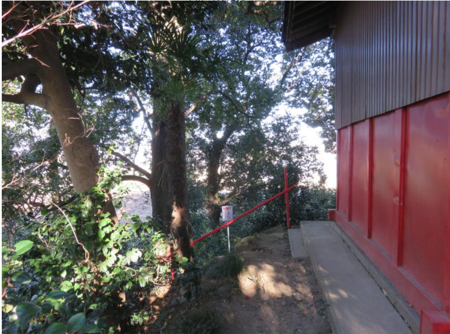
本殿の背後を見たところ
