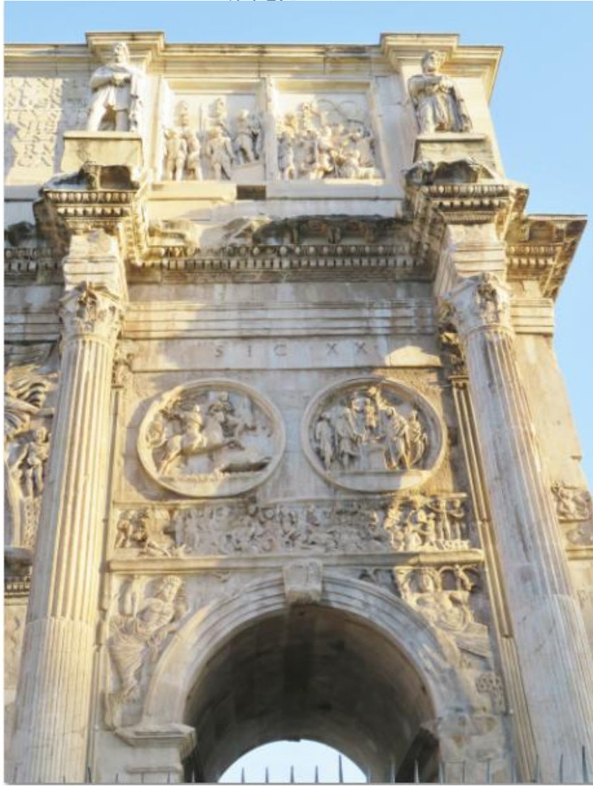
端部を見上げたところ
