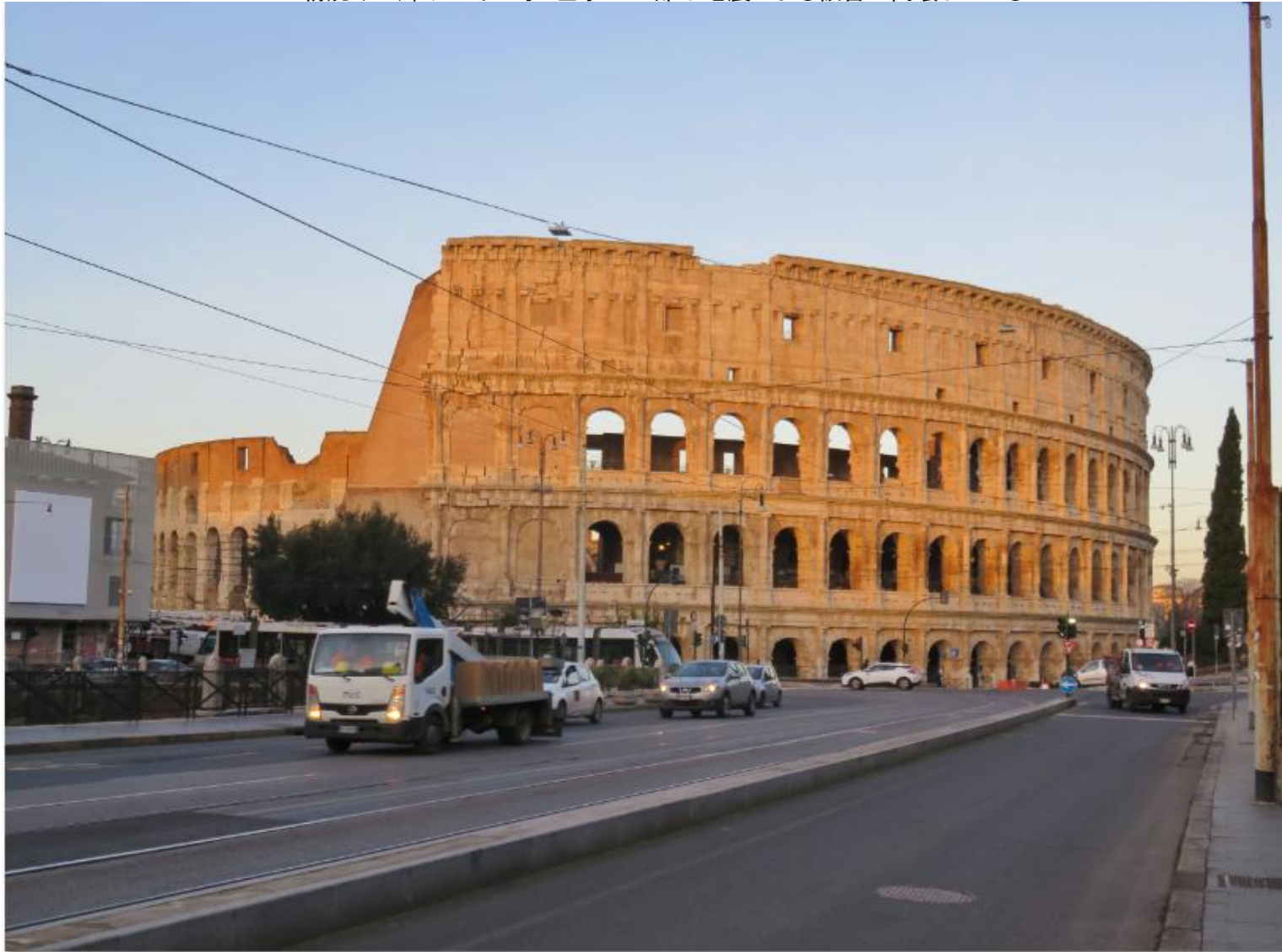
朝焼けに輝くコロッセオ/左手の上部は地震による被害で倒壊している
