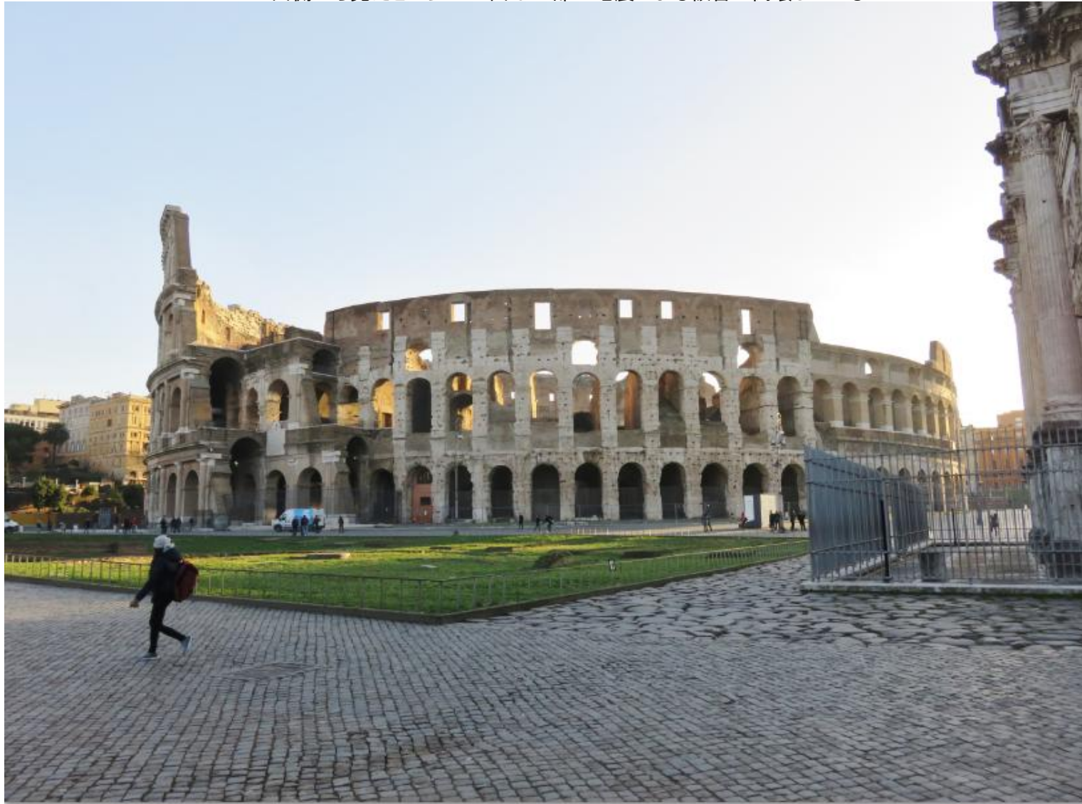
西側から見たところ/この面は上部が地震による被害で倒壊している
