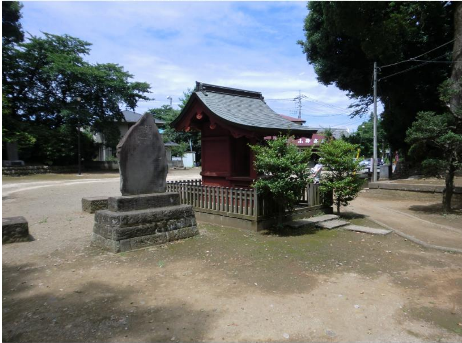
大黒社本殿/一間社流造、見世棚造(みせだなづくり)/屋根は柿葺形銅板葺
