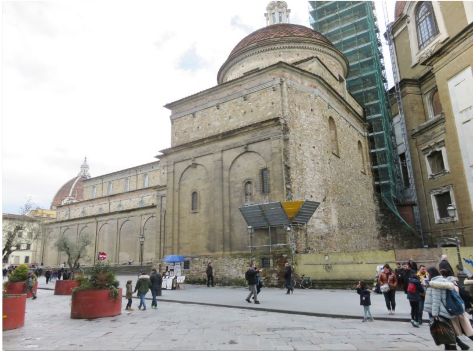
その後方から前面方向を見たところ
