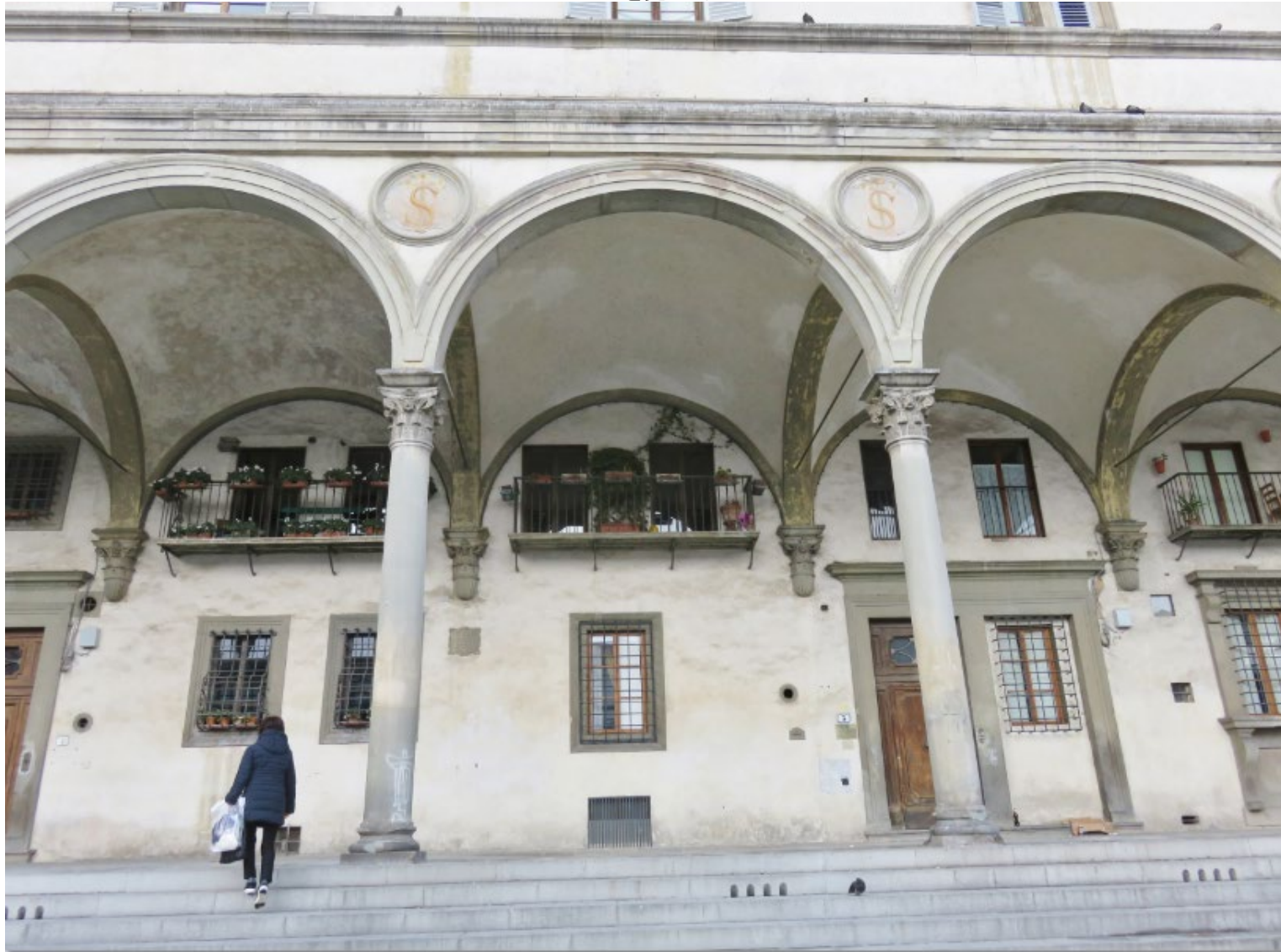
アーケードを見上げたところ
