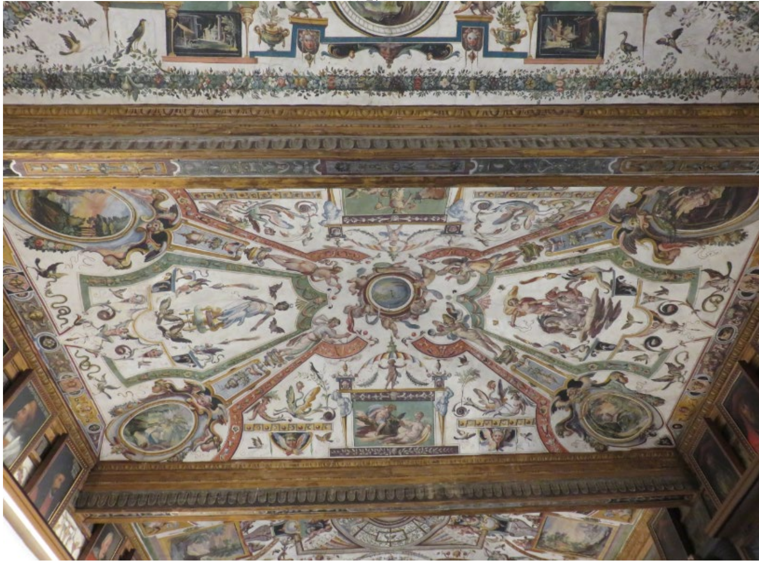
天井を見たところ
