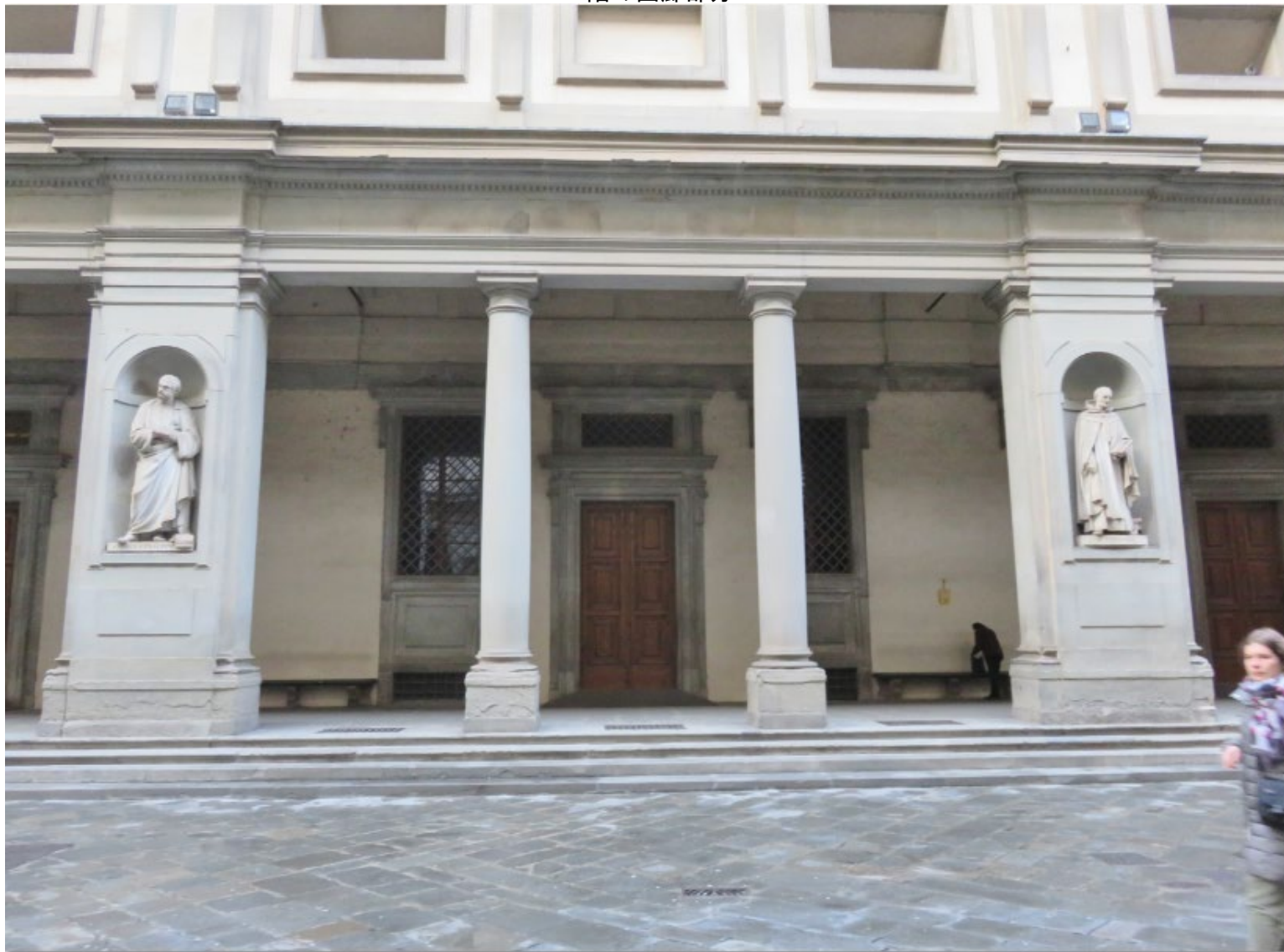
1階の回廊部分
