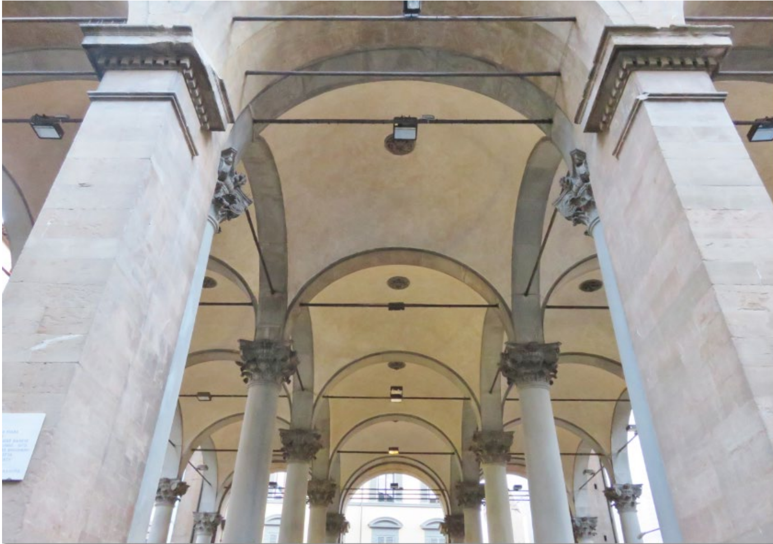
天井を見たところ
