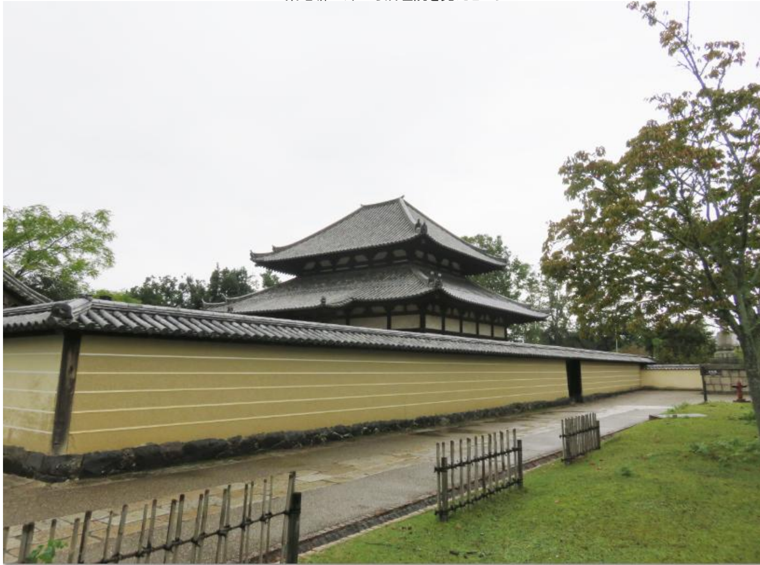
築地塀の外から戒壇院を見たところ
