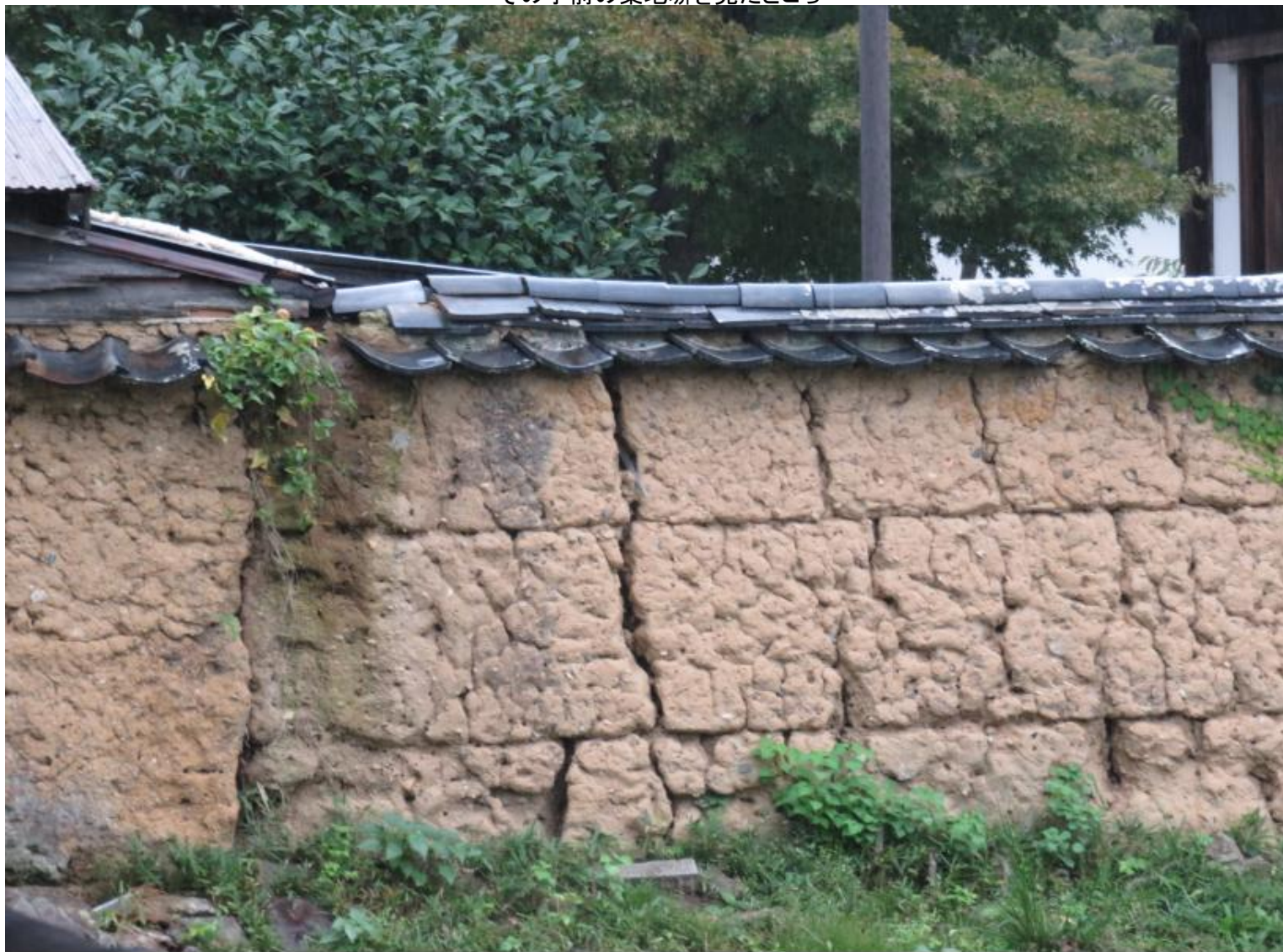
その手前の築地塀を見たところ
