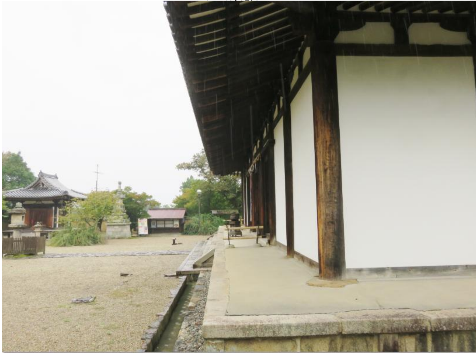
入面の軒裏を見たところ
