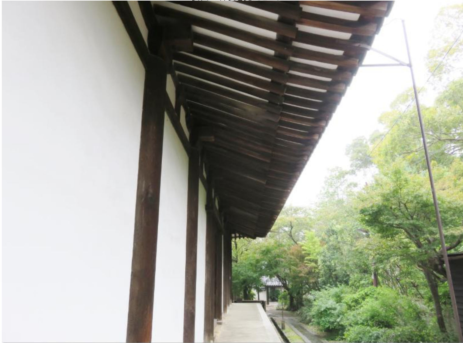
妻面の軒裏を見たところ
