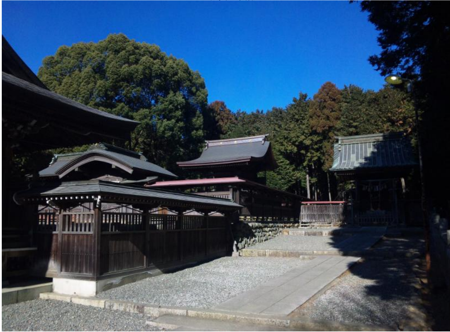
正面奥が本殿
