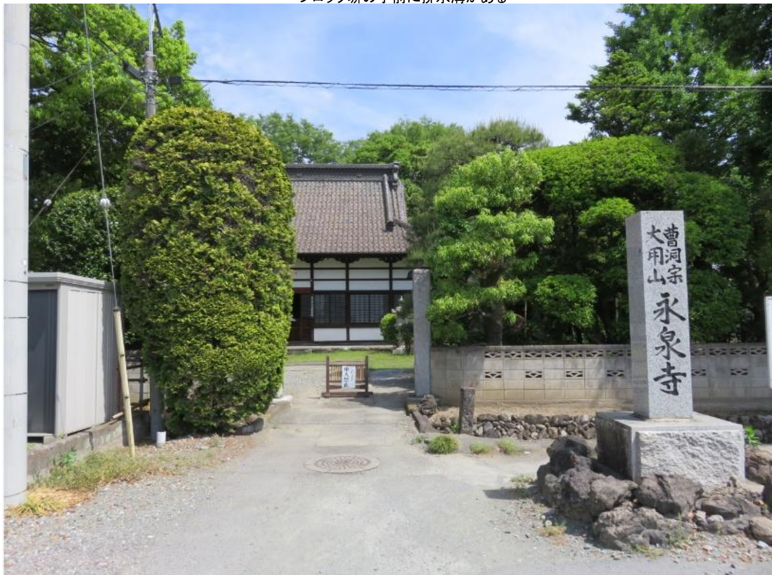
ブロック塀の手前に排水溝がある
